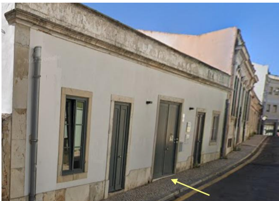
Fig. II.3 – Fachada norte do edifício NOW Beato 1904, com indicação da porta principal.
