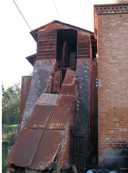
Figura 19 - Fotografia de uma parte do sistema de transmissão por cabos
