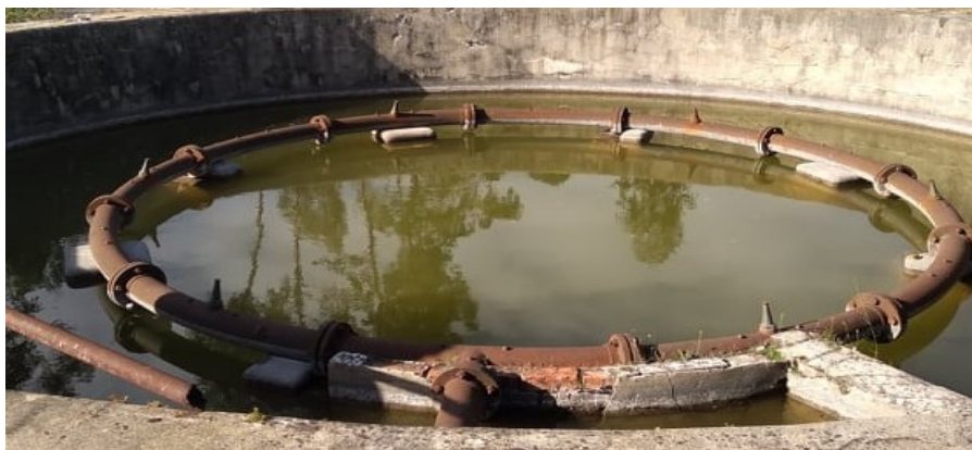
Figura 29 - Fotografia do tanque de refrigeração
