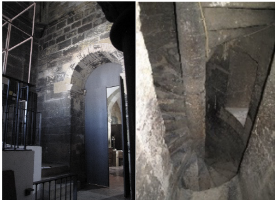
Fig 14. Sala do 1º piso da torre Norte: porta de acesso à galeria para escada de caracol para o 2º piso
