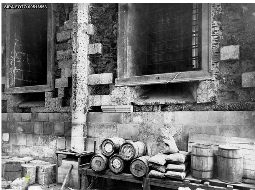
Fig 65. Nave lateral: paredes durante as obras – mais uma vez são alteradas as janelas das naves laterais.
