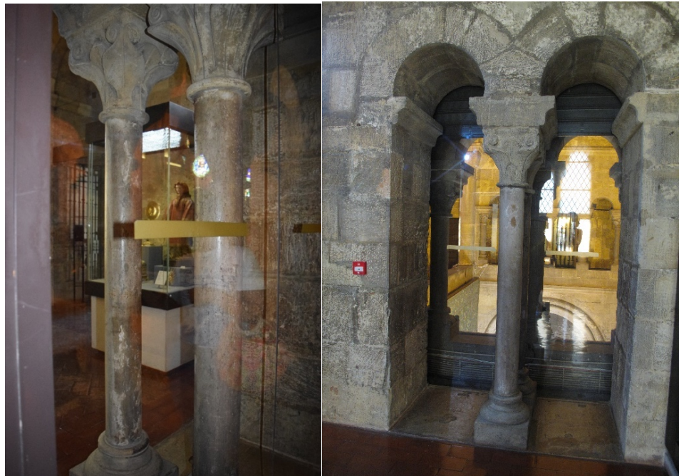
Fig 31. Vão geminado no segundo tramo do trifório (para a sala do 1º piso Sul)
