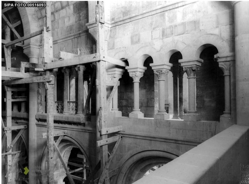
Fig 66. Picagem das colunas do trifório no segundo tramo e o novo trifório já pronto no segundo tramo – podemos observar a grande alteração no desenho e proporção desta estrutura, levada a cabo por Couto Abreu.
