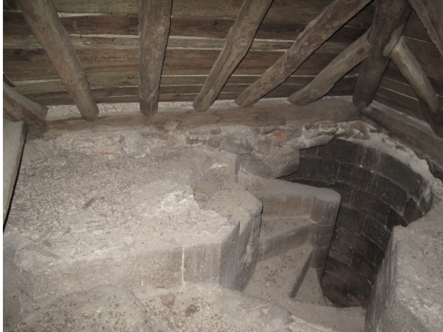
Fig 45. Escadas de acesso do trifório para a cúpula: Norte
