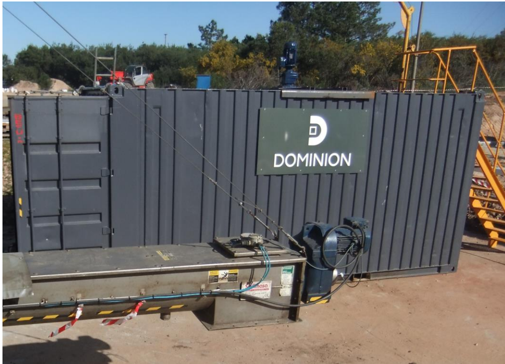
Figura 3.5 - Tanque pulmão da unidade real da Refinaria de Sines.
