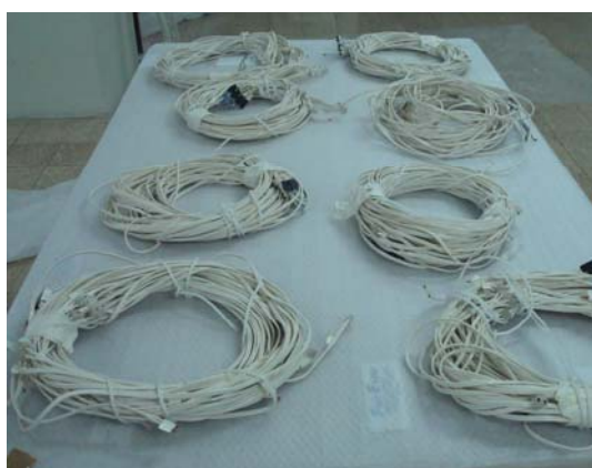
Fig.27 - Meadas de cabos eléctricos.
