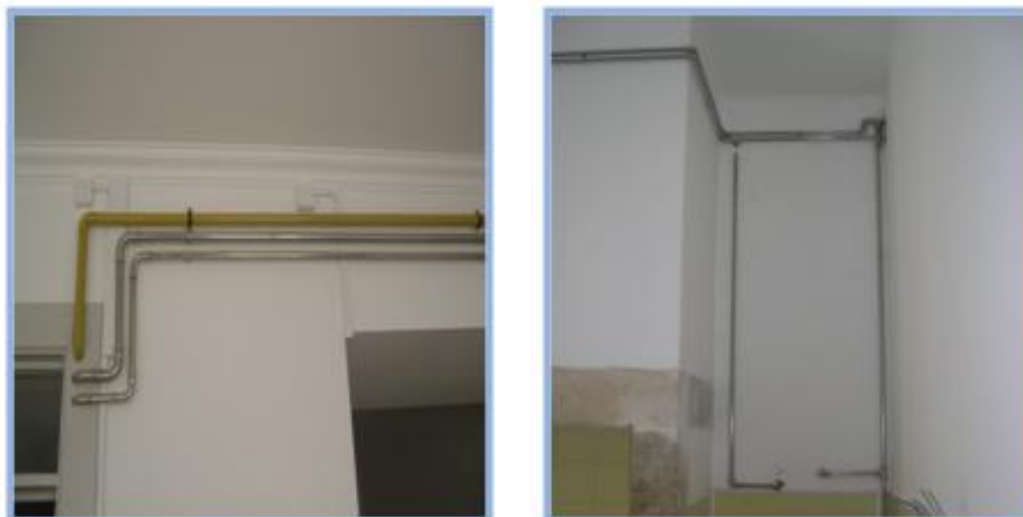
Figura 16 - Tubos de aço inox instalados em obra (Série 1).
