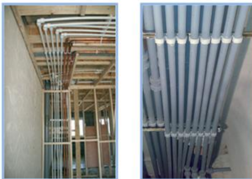
Figura 28 - Tubos de polibutileno instalados em obra [50].
