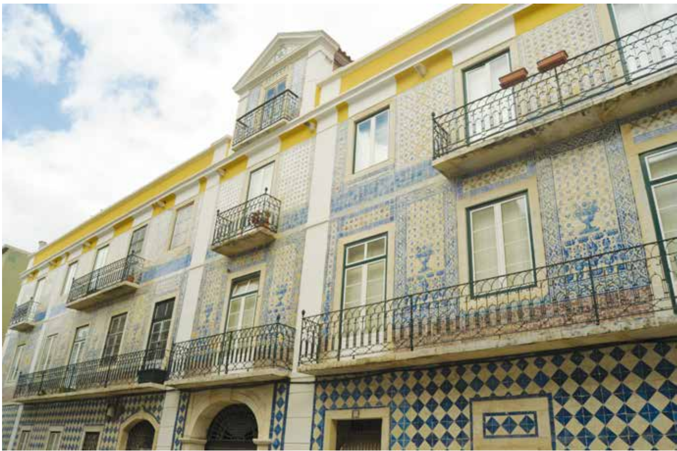
Fig. 21 e 21a – Rua do Andaluz, n.ºs 46-50 «Quinta da Cruz do Tabuado». Edificada depois de 1842 para António Lima Mayer.
