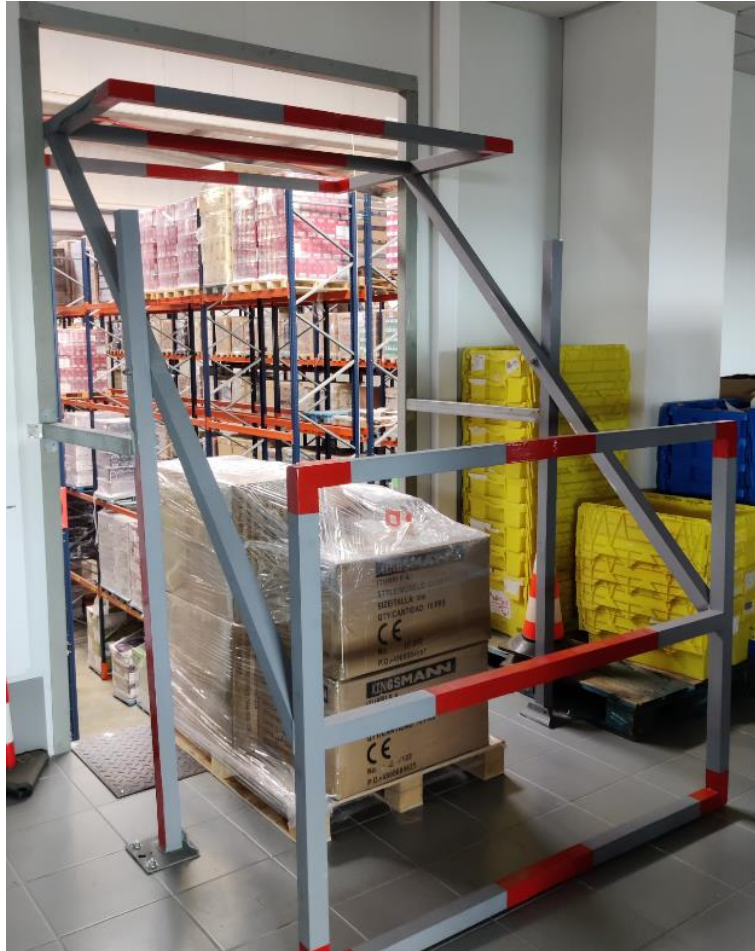
Figura 3.9 – Zona de carga e descarga do armazém
