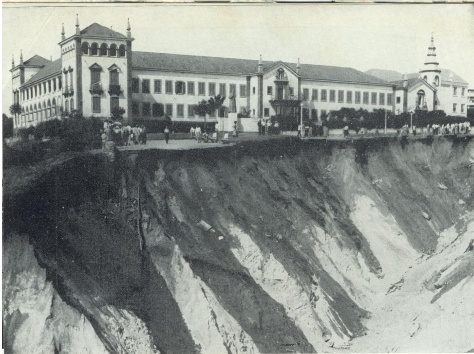
Fig. 15: Efeitos provocados pelas enxurradas de Abril de 1962
