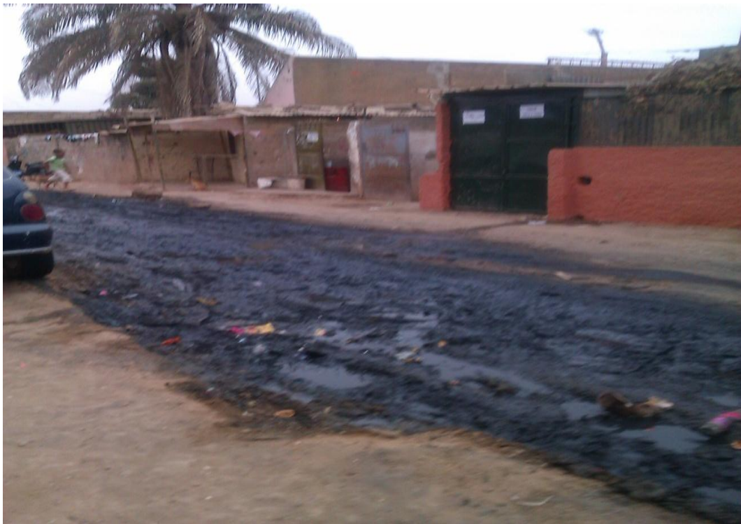
Fig.20: Esgoto a céu aberto, Julho de 2012.
