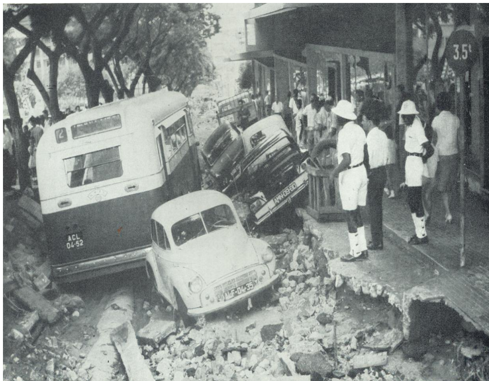
Fig. 16: Efeitos provocados pelas enxurradas de Abril de 1962
