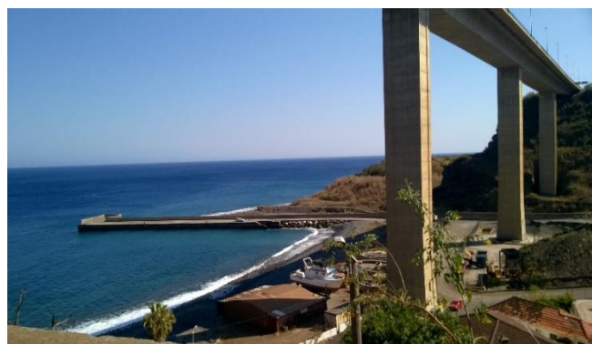
Figura 20 – Terminal de Inertes do Porto Novo. Autoria Própria.
