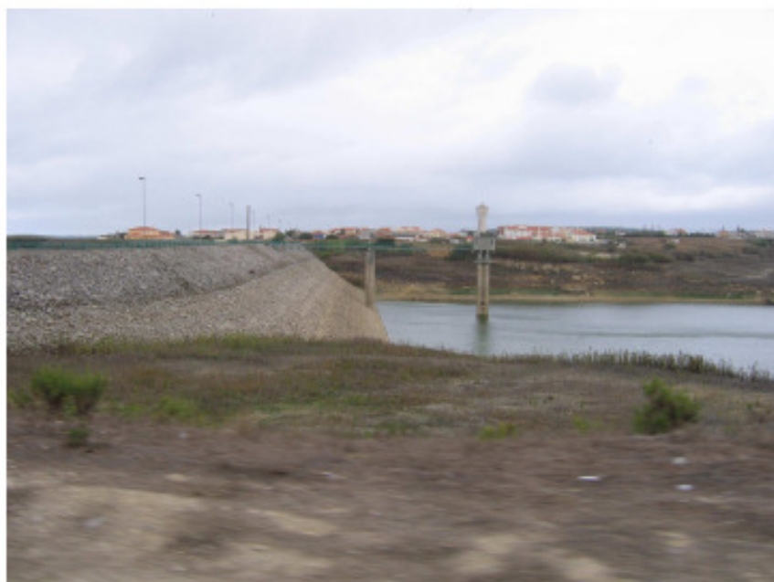
Figura 4.11 – Zona do viaduto em que o IP6 atravessa a albufeira de São Domingos e torre de captação de água (fonte: BARBOSA et al. , 2006)
