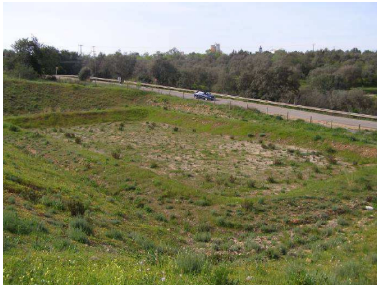
Figura 4.17 – Bacia de infiltração do sistema designado BTA ao km 38+656 da A22, lanço Alcantarilha-Guia (fonte: LNEC, 2008)
