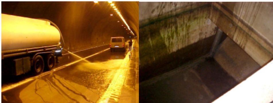
Figura 2.4 - Operação de lavagem do Túnel da Gardunha e tanque separador de hidrocarbonetos vazio, antes da afluência das águas de lavagem (fonte: ANTUNES e BARBOSA, 2005)
