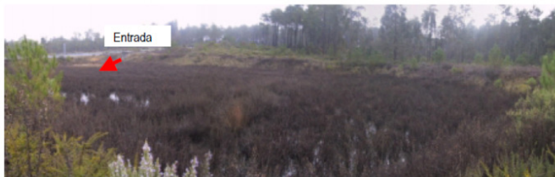
Figura 4.2 - Aspecto da bacia da A1 em Janeiro de 2002, após obras de reabilitação efectuadas em 2000 (foto tirada próximo do descarregador de superfície) (fonte: LEITÃO et al. , 2005)
