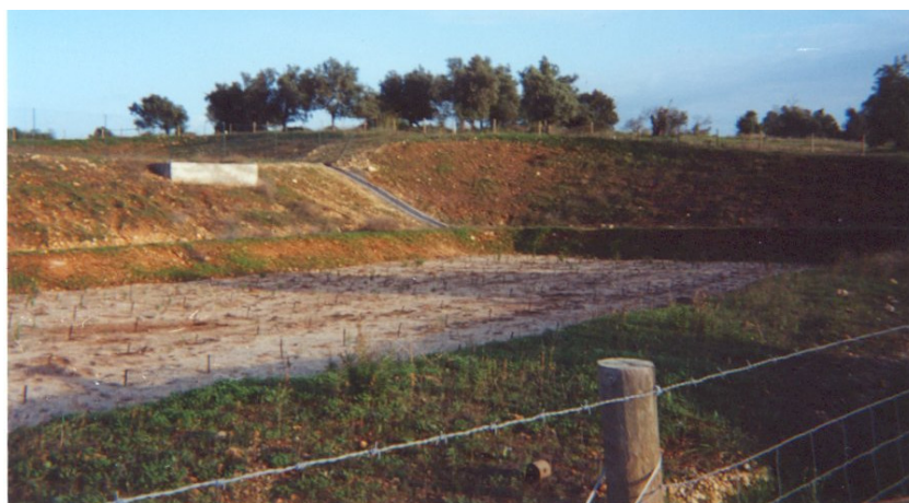
Figura 4.14 – Bacia de infiltração da A22, lanço Guia-Alcantarilha (fonte: TEIXEIRA D'AZEVEDO, 2001)
