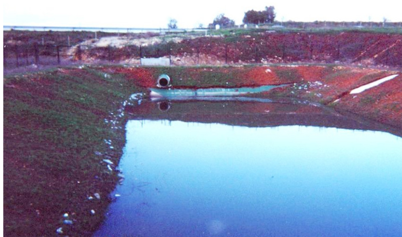
Figura 4.13 – Bacia de retenção/decantação da A22, lanço Guia-Alcantarilha (fonte: TEIXEIRA D'AZEVEDO, 2001)
