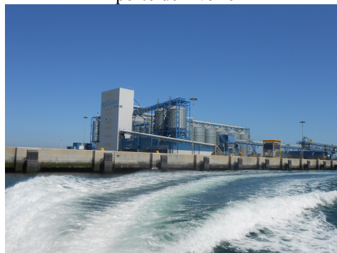
Figura 67: Terminal de granéis sólidos no porto de Aveiro
