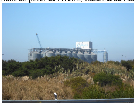
Figura AV-2: Sograin no terminal de granéis sólidos do porto de Aveiro, Gafanha da Nazaré
