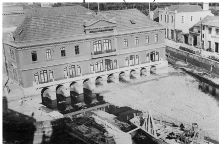
Figura 30: Construção do cais junto à Capitania (1958)
