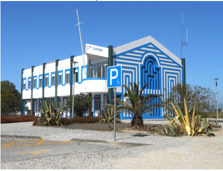
Figura AV-7: Capitania do porto de Aveiro no terminal norte, Gafanha da Nazaré
