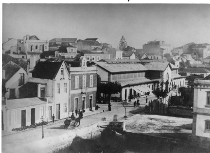
Figura 28: Ligação entre ponte-praça e avenida Dr. Lourenço Peixinho
