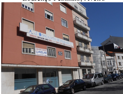
Figura AV-20: Operador portuário na Av. Dr. Lourenço Peixinho, Aveiro
