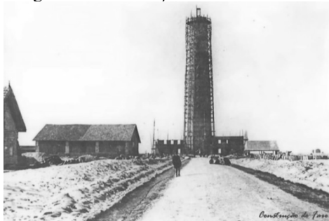
Figura 24: Construção do farol da Barra
