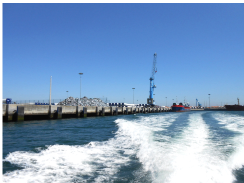
Figura AV-29: Cais de carga de resíduos metálicos no terminal de granéis sólidos
