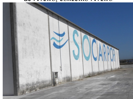
Figura AV-5: Socarpor no terminal sul do porto de Aveiro, concelho Aveiro
