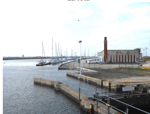
Figura 36: Abandono do edifício da lota. Marina da lota
