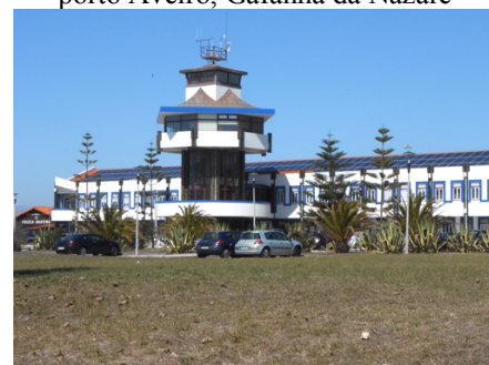
Figura AV-6: Sede APA no terminal norte do porto Aveiro, Gafanha da Nazaré
