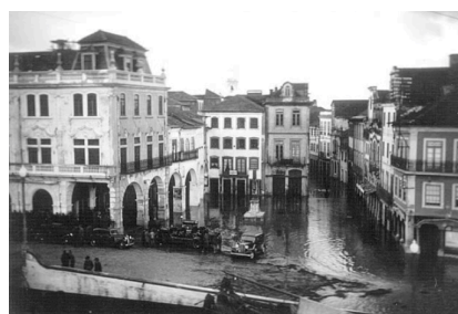
Figura 33: Inundações em 1938 junto ao canal Central e Praça Melo Freitas
