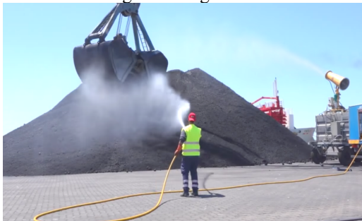
Figura 76: Pulverização do petcoke com canhão de água e mangueiras
