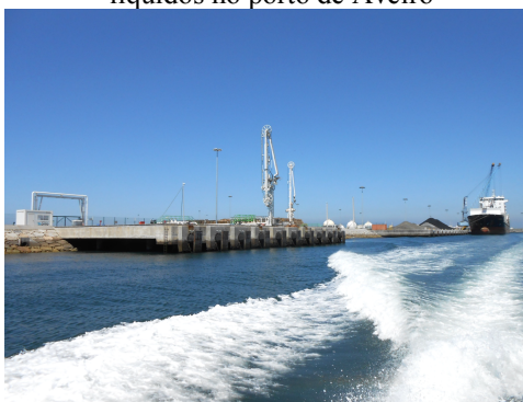
Figura AV-28: Cais de acostagem de gran is l quidos no porto de Aveiro
