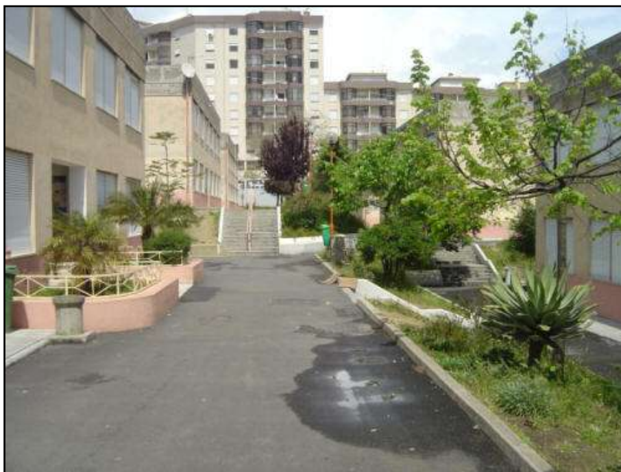
Figura 3.6 Vistas do interior da escola.
