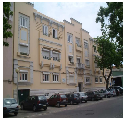
Fig. 2- Instalações da UNISETI 14
