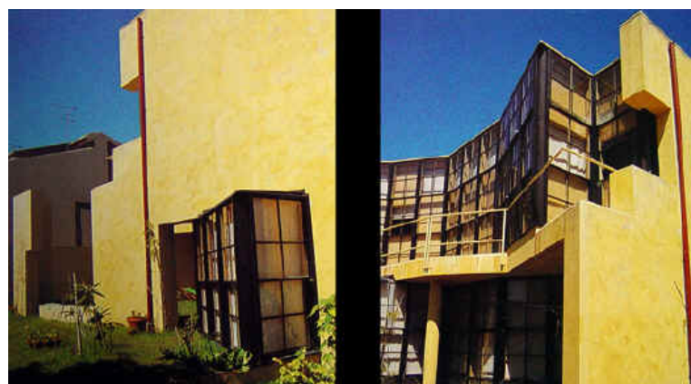
Fig. 19 - Vista geral do edifício
