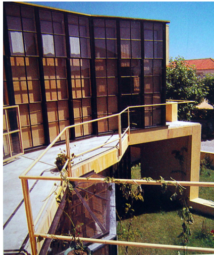
Fig. 21 - Pormenor da fachada irregular
