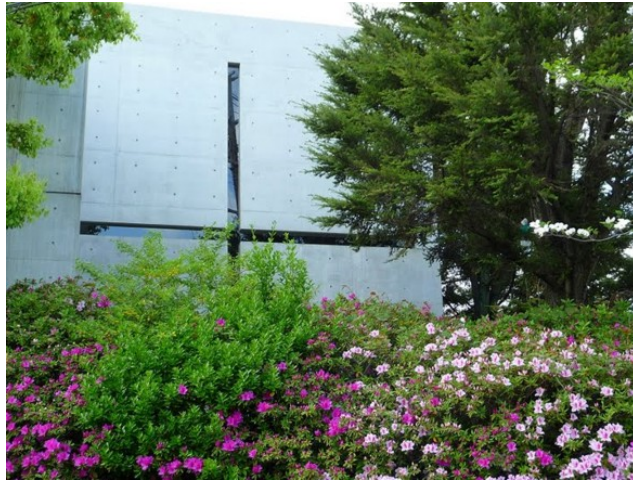
Fig. 53 - Pormenor do exterior
