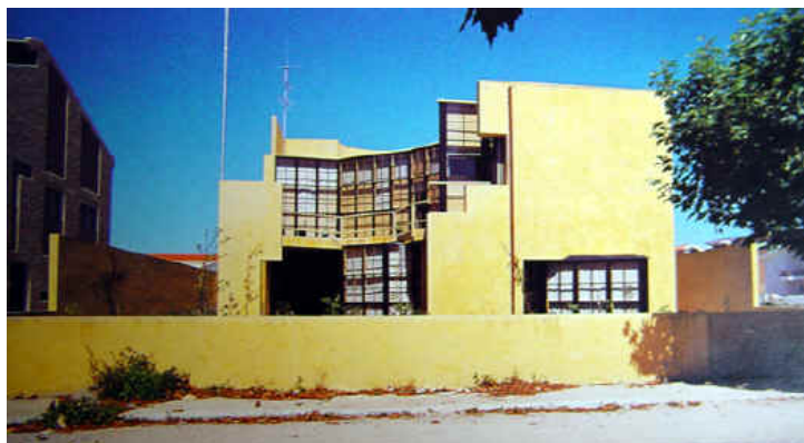
Fig. 18 - Vista geral do edifício
