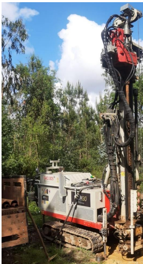
Figura 3.5 - Execução de uma sondagem geotécnica com recursos ao devido equipamento.
