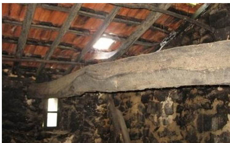
Fig. 2.9 – Viga de madeira apoiada em parede de alvenaria de pedra [53]
