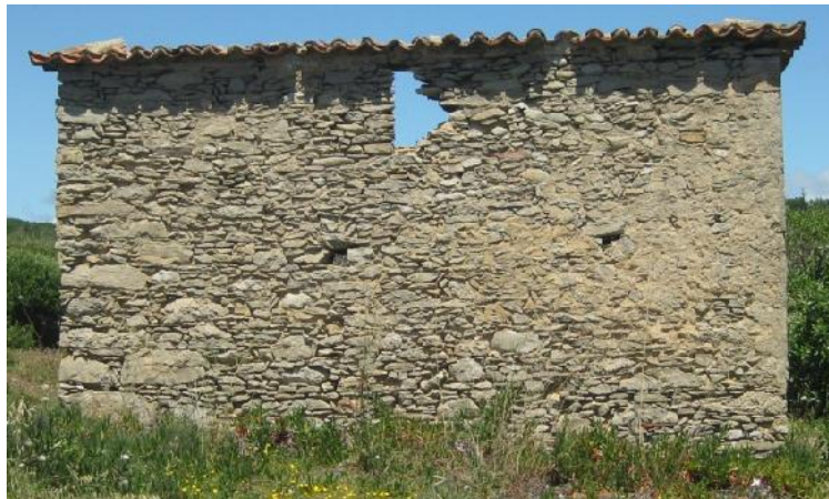
Fig. 1.1 – Edifício antigo de alvenaria de pedra
