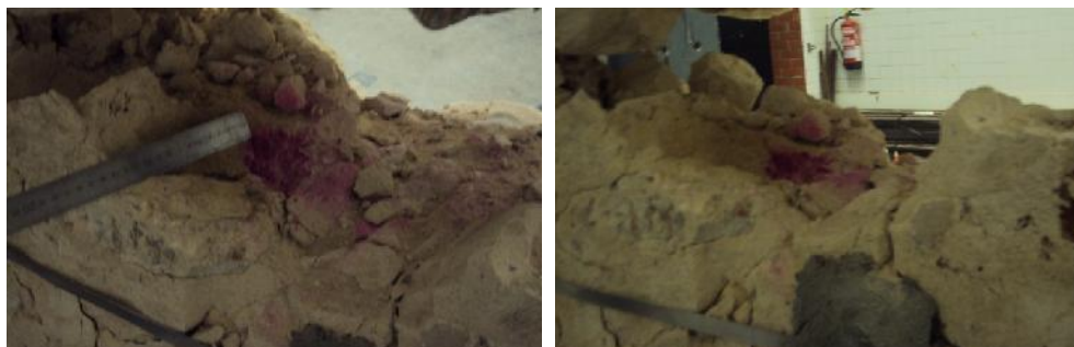
Fig. 5.10 – Medição da profundidade de carbonatação do murete
