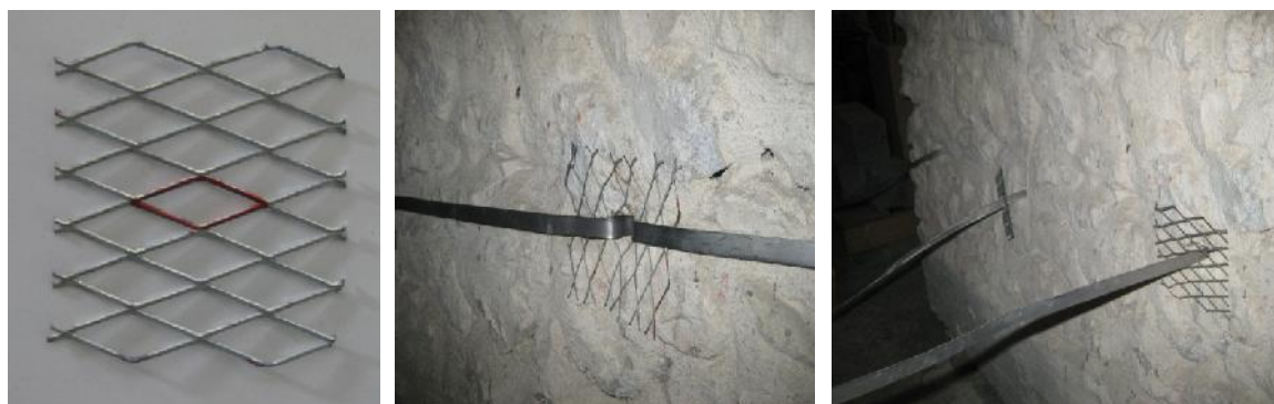
Fig. 4.5 – Colocação da rede de metal distendido à passagem da fita em cada furo
