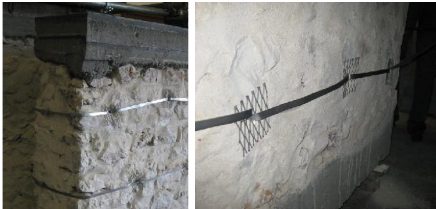
Fig. 4.6 – Realização da passagem das fitas pelos furos no murete
