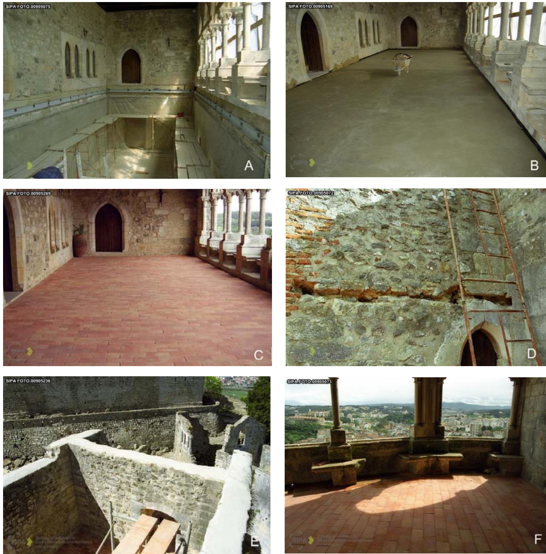
Figura 9.19 – Intervenções DGEMN: Remoção do antigo pavimento e colocação do novo em tijoleira na Loggia (imagem A, B e C) e remoção de canalizações e preenchimentos com argamassa (imagem D), capeamento (Imagem E) colocação do pavimento novo em tijoleira na galeria Sudeste dos Paços Novos (imagem e G) (De: SIPA FOTO0090 (5075), (5169), (5269), (5072), (5236), (5025)), vistas a 22-10-2012.
