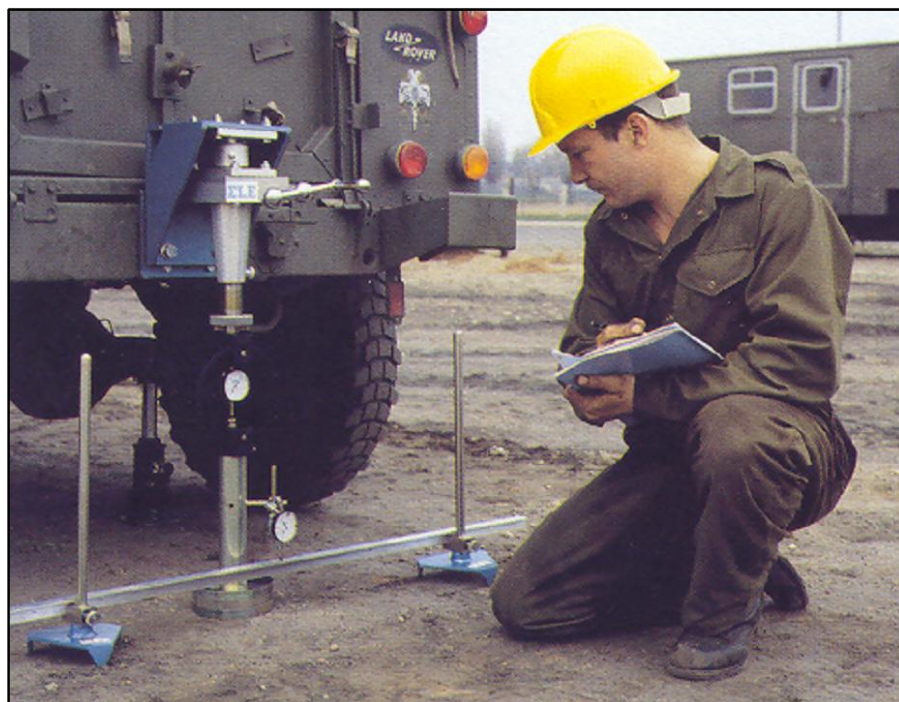
Figura 3.7 - Realização de ensaio CBR in situ (Rocamix)
