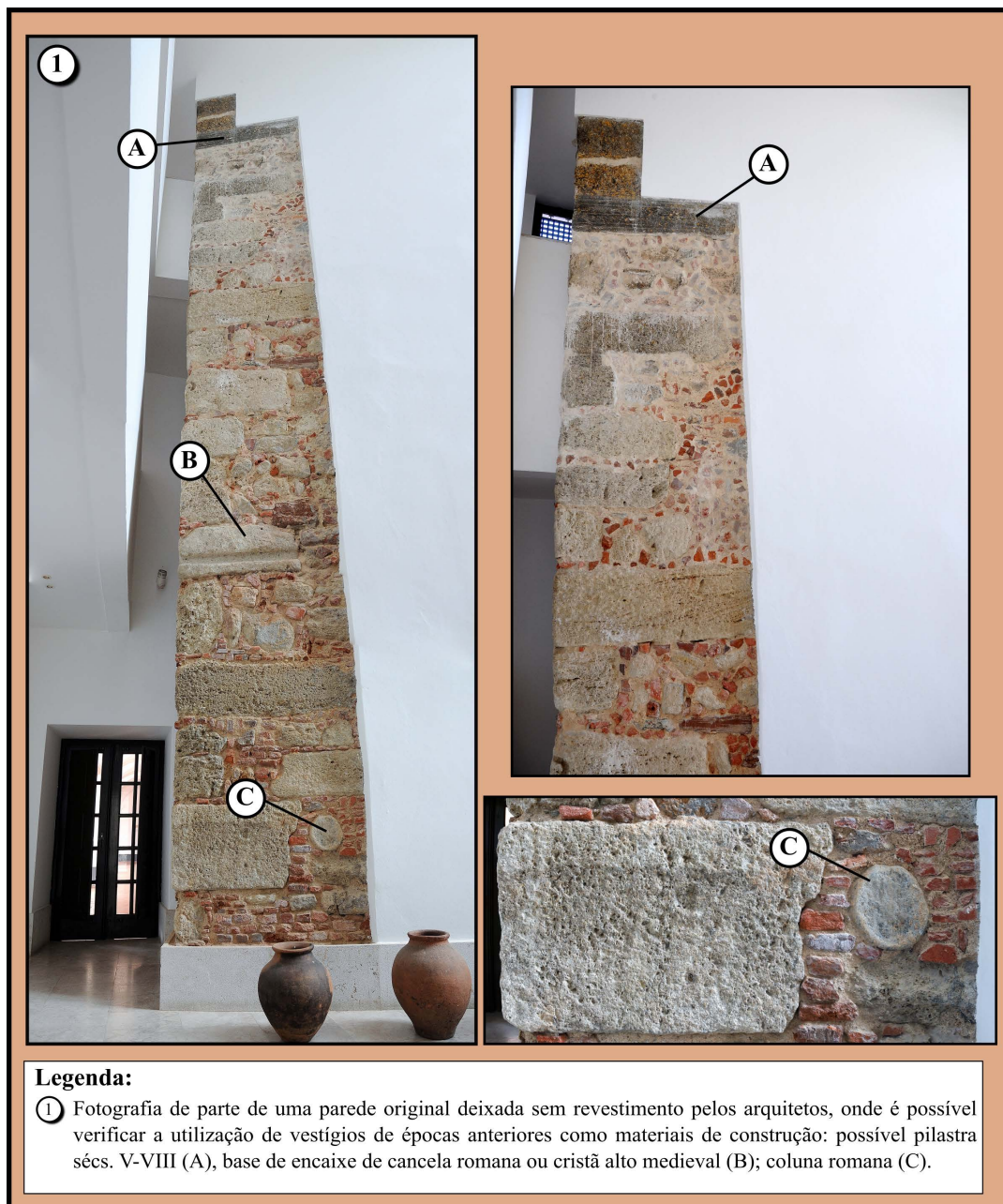
Figura nº 2: Parede com vestígios materiais de épocas anteriores deixada após as obras de restauro do convento.
