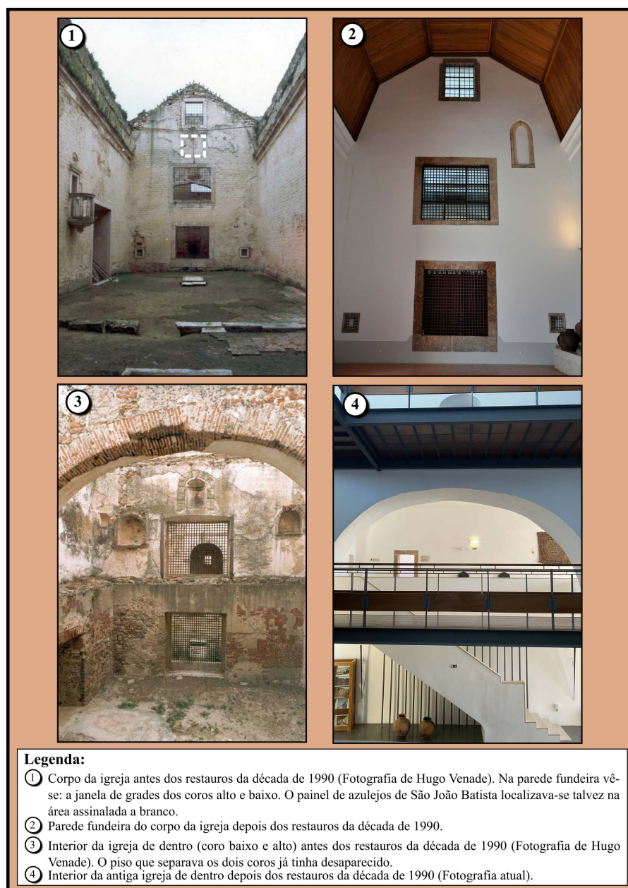
Figura nº 16: O corpo da igreja e os coros antes e após os restauros (década de 1990).
