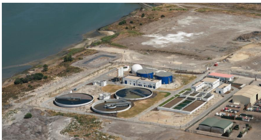
Figura 3.4 – Vista aérea da ETAR do Seixal (SIMARSUL, 2014).
