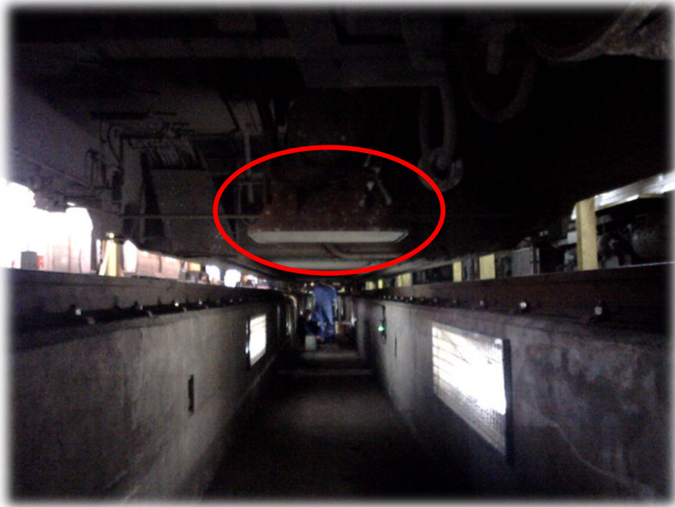
Figura 3.10 - Componente antena do sistema reparável SCI
