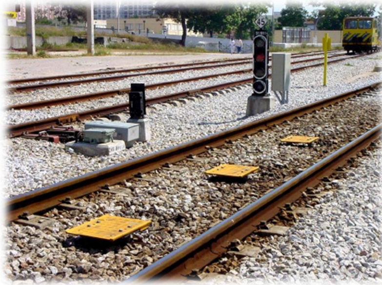
Figura 3.9 – Balizas em plena via
