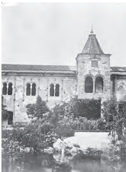
Imagem 2: Anónimo (ant. 1863) – Palácio de D. Manuel após incêndio . Propriedade do Arquivo Fotográfico da CME.
