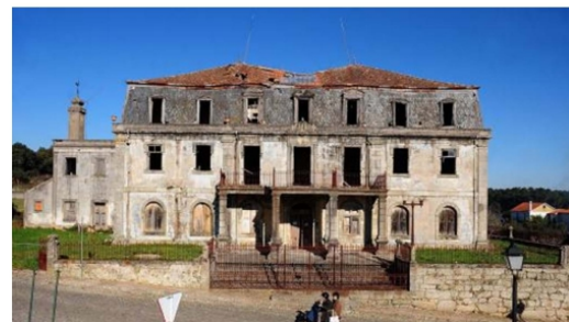
Casa do Passal, casa de família de Aristides de Sousa Mendes, antes da recuperação do exterior.
