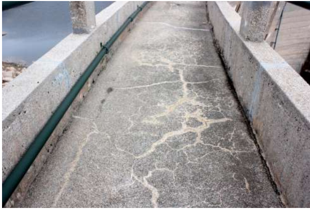
Figura 1.4 - Fendilhação difusa, do tipo craquelê , no piso do coroamento da barragem do Covão do Meio (à esquerda) e fendilhação linear no piso do coroamento da barragem de Santa Luzia (à direita)
