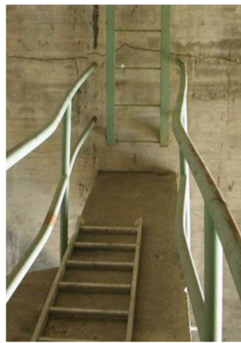
Figura 1.6 - Comportas com guias laterais ajustadas e zonas de amarração reforçadas com pré-esforço, na barragem de Hiwassee (à esquerda) e encurvadura de guardas em vão da barragem de Hunderfossen, na Noruega (à direita) (Batista, 2021)
