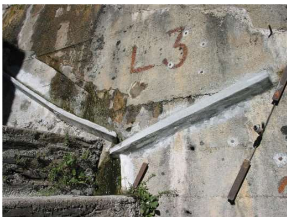
Figura 1.9 – Vista de bicas no paramento de jusante para coletar repasses pelas fendas do betão na barragem do Alto Ceira, em 2012 (à esquerda), e na barragem de Peti (Brasil), em 2011 (à direita)
