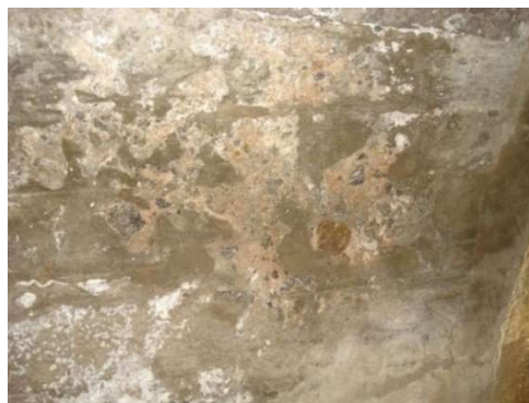
Figura 1.7 – Aspeto amarelado do betão da barragem do Alto Ceira (bloco que está no campus do LNEC, fotografado em 2020) (à esquerda) e hasteal de uma galeria com betão deteriorado superficialmente na barragem de Bem-posta, em 2013 (à direita)
