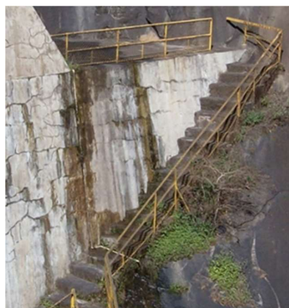
Figura 1.9 – Vista de bicas no paramento de jusante para coletar repasses pelas fendas do betão na barragem do Alto Ceira, em 2012 (à esquerda), e na barragem de Peti (Brasil), em 2011 (à direita)
