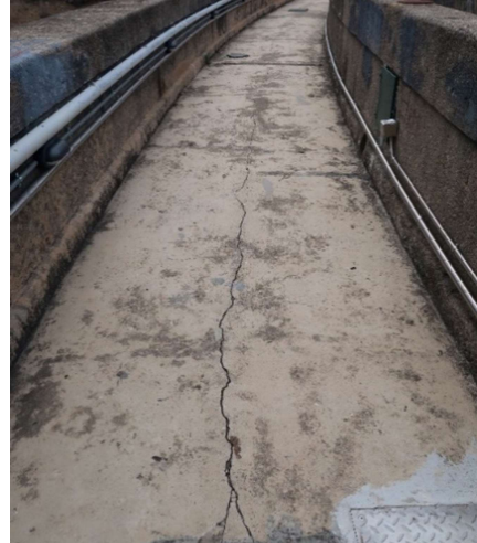
Figura 1.4 - Fendilhação difusa, do tipo craquelê , no piso do coroamento da barragem do Covão do Meio (à esquerda) e fendilhação linear no piso do coroamento da barragem de Santa Luzia (à direita)
