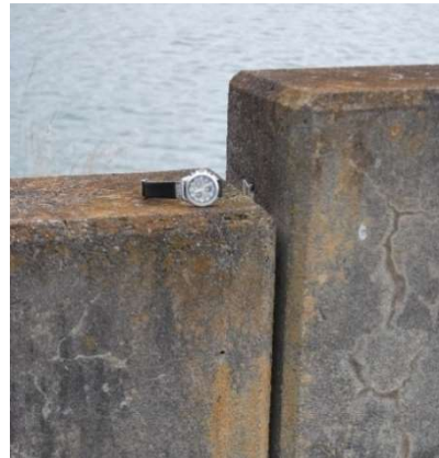
Figura 1.5 - Deslocamentos irreversíveis em juntas de contração no coroamento: na barragem de Miranda, na guarda de montante, com esmagamento de bordos, em 2018 (à esquerda), e na barragem da Fontana (EUA), também na guarda de montante, em 2013 (à direita)
