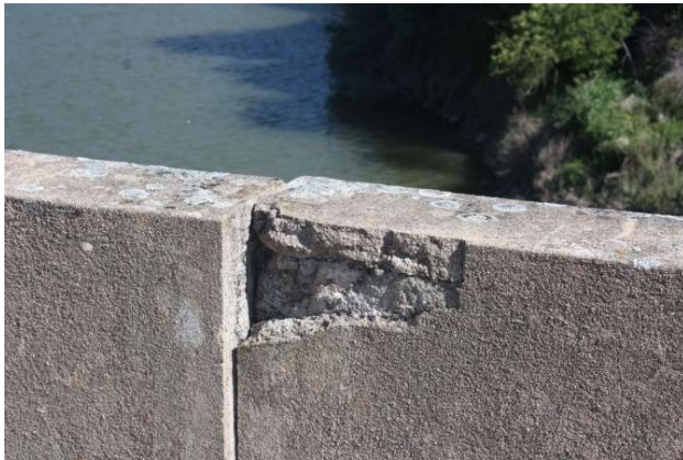
Figura 1.5 - Deslocamentos irreversíveis em juntas de contração no coroamento: na barragem de Miranda, na guarda de montante, com esmagamento de bordos, em 2018 (à esquerda), e na barragem da Fontana (EUA), também na guarda de montante, em 2013 (à direita)
