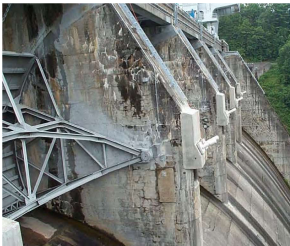
Figura 1.6 - Comportas com guias laterais ajustadas e zonas de amarração reforçadas com pré-esforço, na barragem de Hiwassee (à esquerda) e encurvadura de guardas em vão da barragem de Hunderfossen, na Noruega (à direita) (Batista, 2021)
