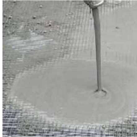
Figura 2.7 - Pormenor de infiltração de calda na micro-malha (Schneide & Reymendt, 2008)
