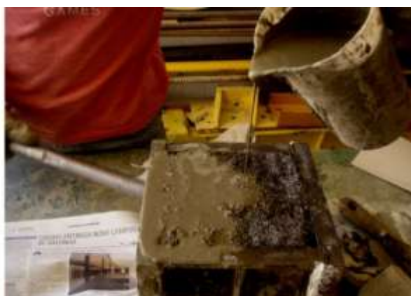
b) Betonagem com auxílio de vibração exterior do molde
