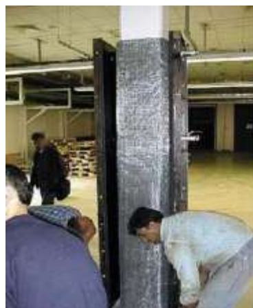
Figura 2.9 - Reforço de pilar, em estrutura existente, para protecção sísmica (Schneide & Reymendt, 2008)
