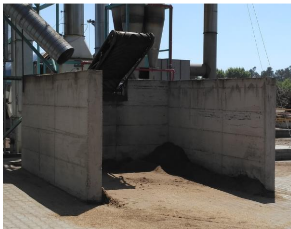
Figura 5.55 - Bloco de descarga
