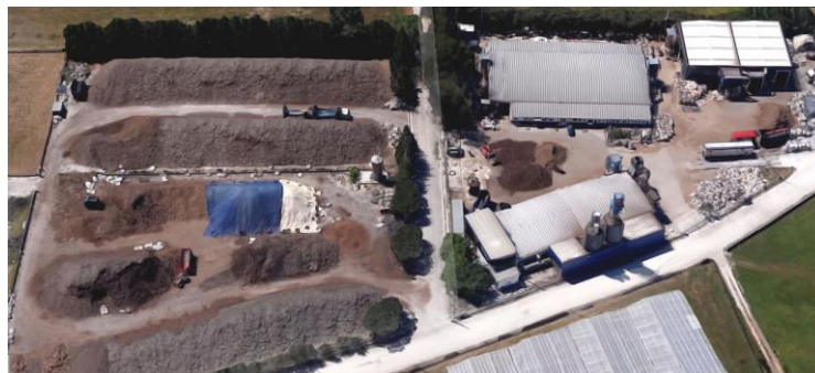
Figura 3.1 - Vista aérea da fábrica por altura da sua abertura (ReginaCork, 2019)
