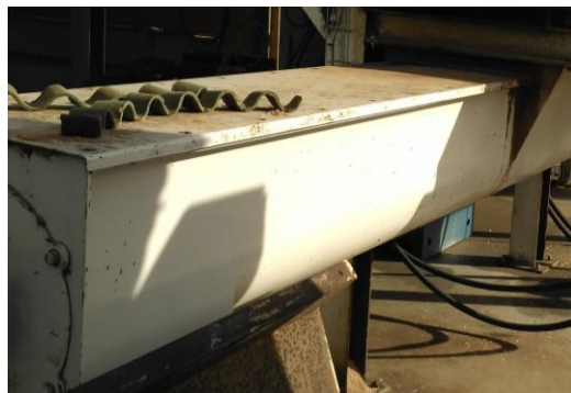
Figura 5.43 - Estrutura exterior do transportador
