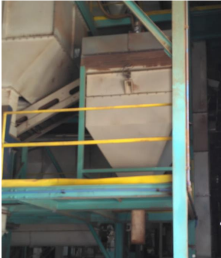
Figura 5.30 - Mecanismo de ensacamento em Big Bags
