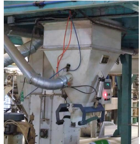
Figura 5.31 - Mecanismo de ensacamento em sacos de 15 kg
