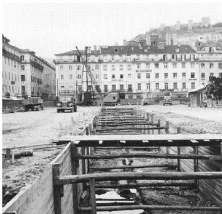
Fig.3: Construção do Metropolitano, 1961. Arquivo Municipal de Lisboa A31661.
