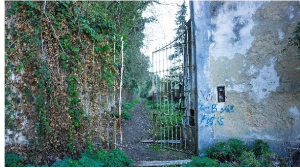
Figura 4.29 - Acesso Interno Complexo – Arealva
