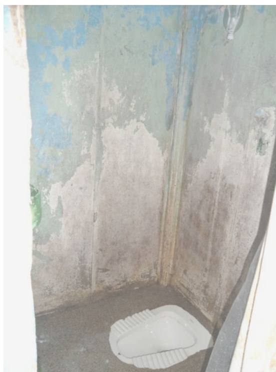
Figura 8: Unidade de Internação do Plano Piloto. Módulo 1. Quarto. Casa de banho. (Fonte: Foto Pessoal)
