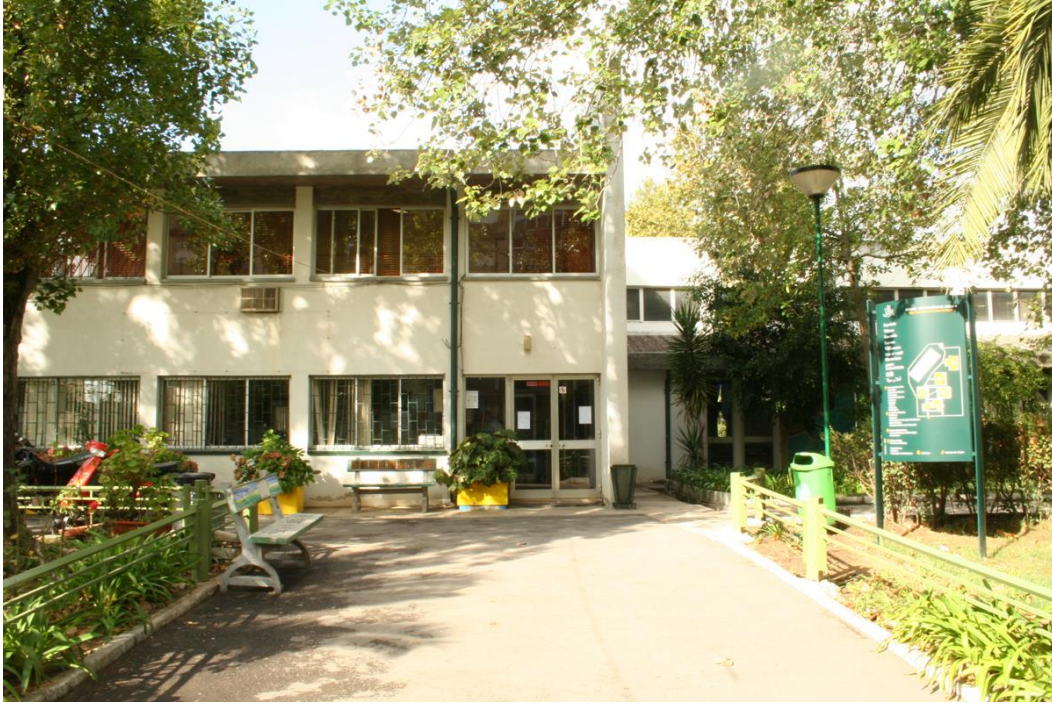
Fig. 5: A entrada da escola antes das obras. Retirado de “Museu Digital”.
