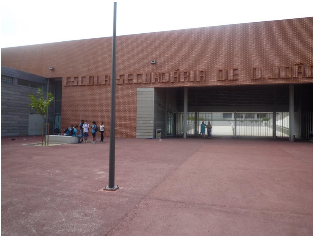
Fig. 6: A entrada da escola depois das obras. Retirado de “Museu Digital”.
