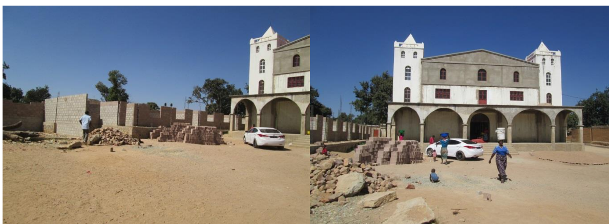
Figura 20. Escola em construção no recinto da igreja
