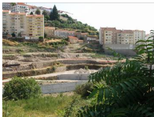
Figura 17 Parque Urbano da Goldra – 2007 (obras finais) Fonte: GCPP
