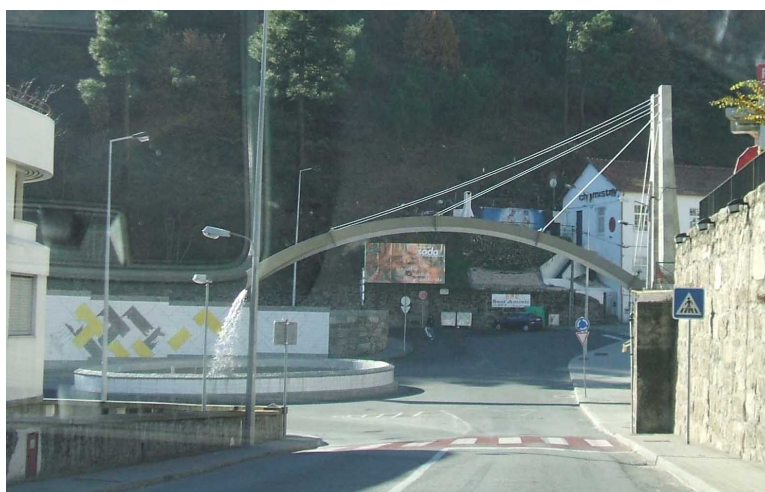
Figura 24 Rotunda da Ponte do Rato – sentido descendente Fonte: Captação do Investigador
