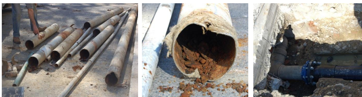
Figura 4.22 – Substituição das tubagens de abastecimento de água da EPAL ao LNEC
