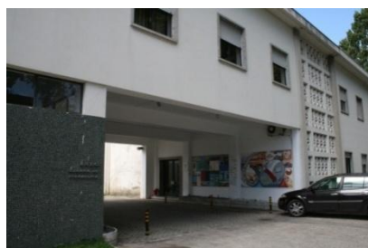
B – Edifício DHA
