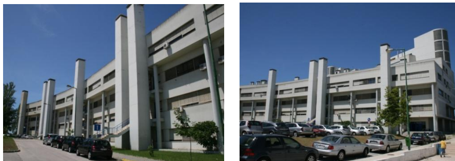
Figura 4.2 - Fotografias do edifício Departamental
