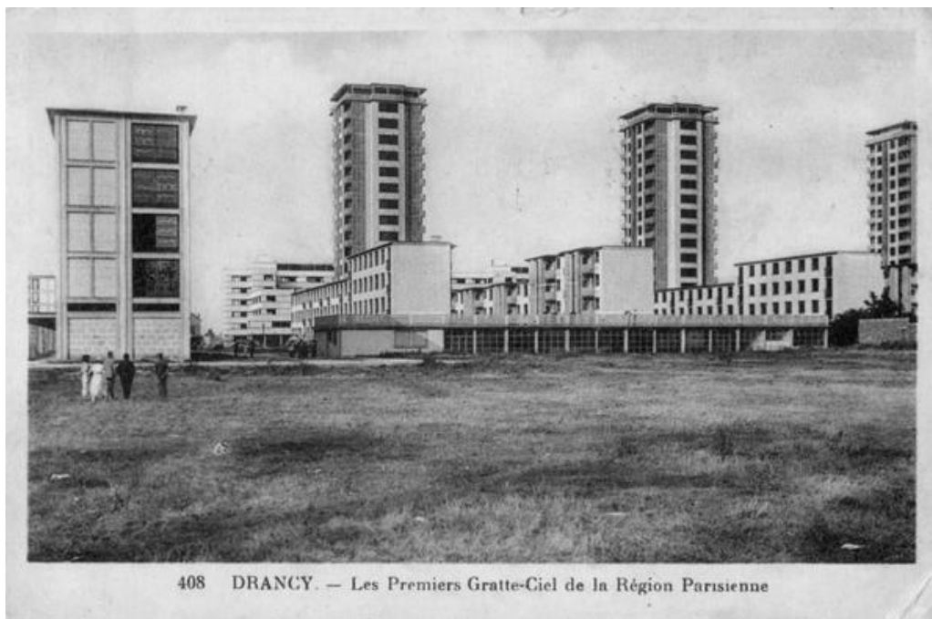
Figura 2.2- Cité de la Muette em Drancy. Postal de época, http://www.pss-archi.eu/forum/viewtopic.php?id=33788 (acedido em 15-04-2012).
