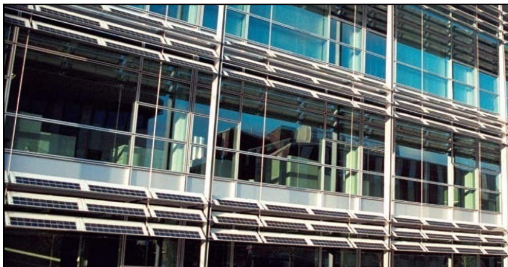
Figura 2.27. Painéis fotovoltaicos com funcionalidades de sombreamento e produção de electricidade, Sunbury Building, Ashford/Reino Unido (Fonte: European Photovoltaic Technology Platform, 2007)
