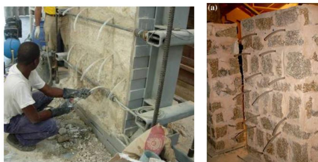
Figura 2.13 - Técnica de aplicação de injeção de grouts (adaptado de:(Almeida et al. , 2012) e (Sofia et al. , 2012))
