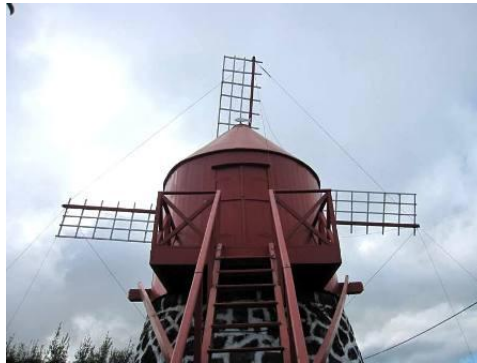
Figura 10 - Entrada para o moinho com escada, varandim e balcão.
