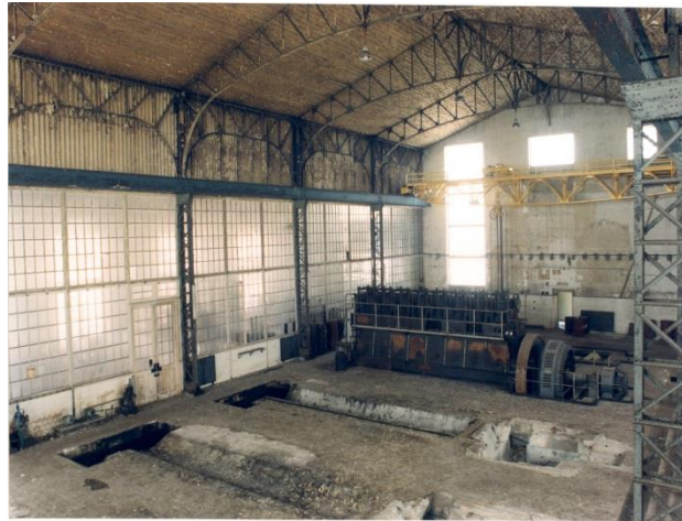
Figura 7 – Desativação total da Central a Diesel , 1998. Fonte: CDMIBdT
