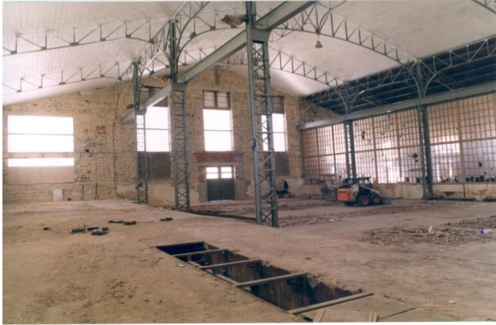
Figura 10 – Reconversão e reabilitação, nave central, 1998. Fonte: CDMIBdT
