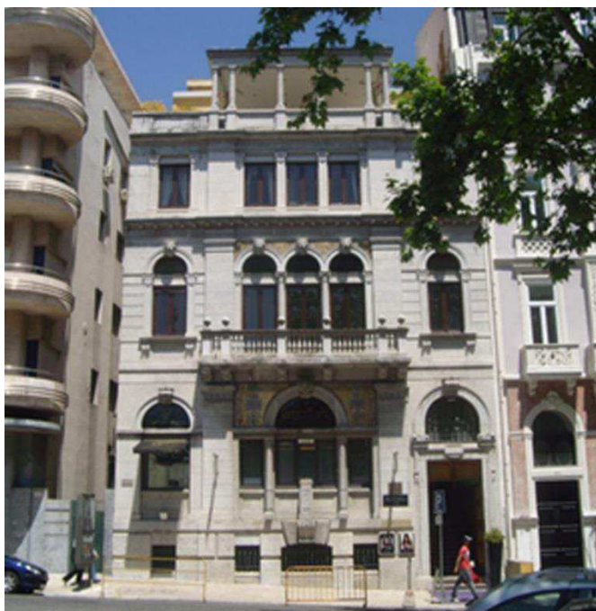
17 – Fachada do Palacete Lambertini.
