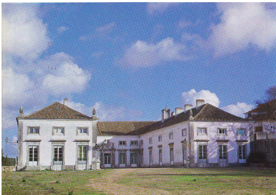
19 – Fachada do Palácio do Calhariz (foto de Maurício de Abreu).
