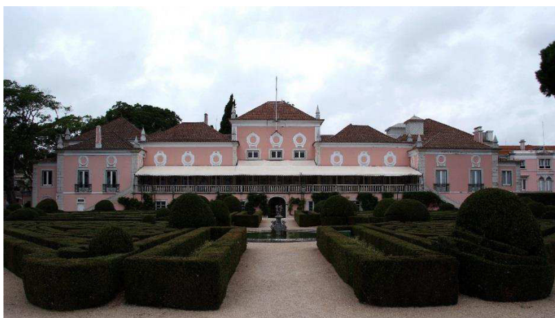
37 – Fachada do Palácio de Belém.
