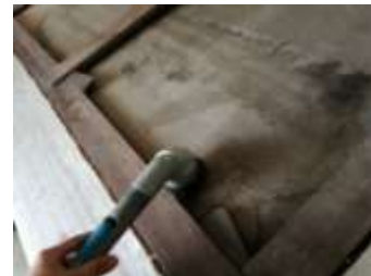
Figura G.1. Pormenor de limpeza superficial com recurso ao aspirador.
