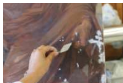
Figura H.9 aplicação de massa de preenchimento com espátula.
