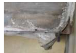
Figura 3.4. Perda de adesão do suporte têxtil à grade, perda de material e zonas de desgaste da camada pictórica. (V.S.)
