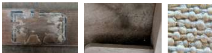
Figura A.6. Pormenor dos vestígios de etiqueta na trave central da grade.
