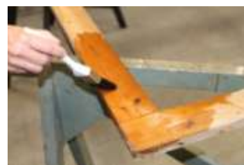
Figura H.5 Aplicação de xilofene na grade.
