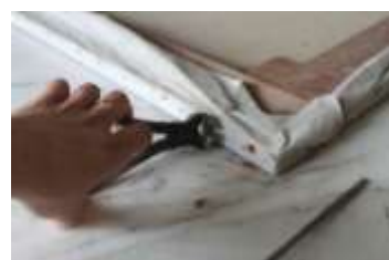
Figura H. 2 Pormenor de desengradamento com a utilização de uma chave de fendas.
