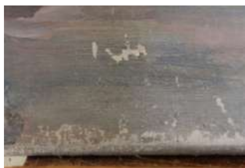
Figura 3.6. Pormenor da perda da camada de tinta ao longo de toda a zona inferior. (V.S.).
