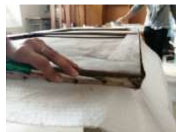
Figura G. 2 Pormenor de desengradamento com a utilização de uma chave de fendas.
