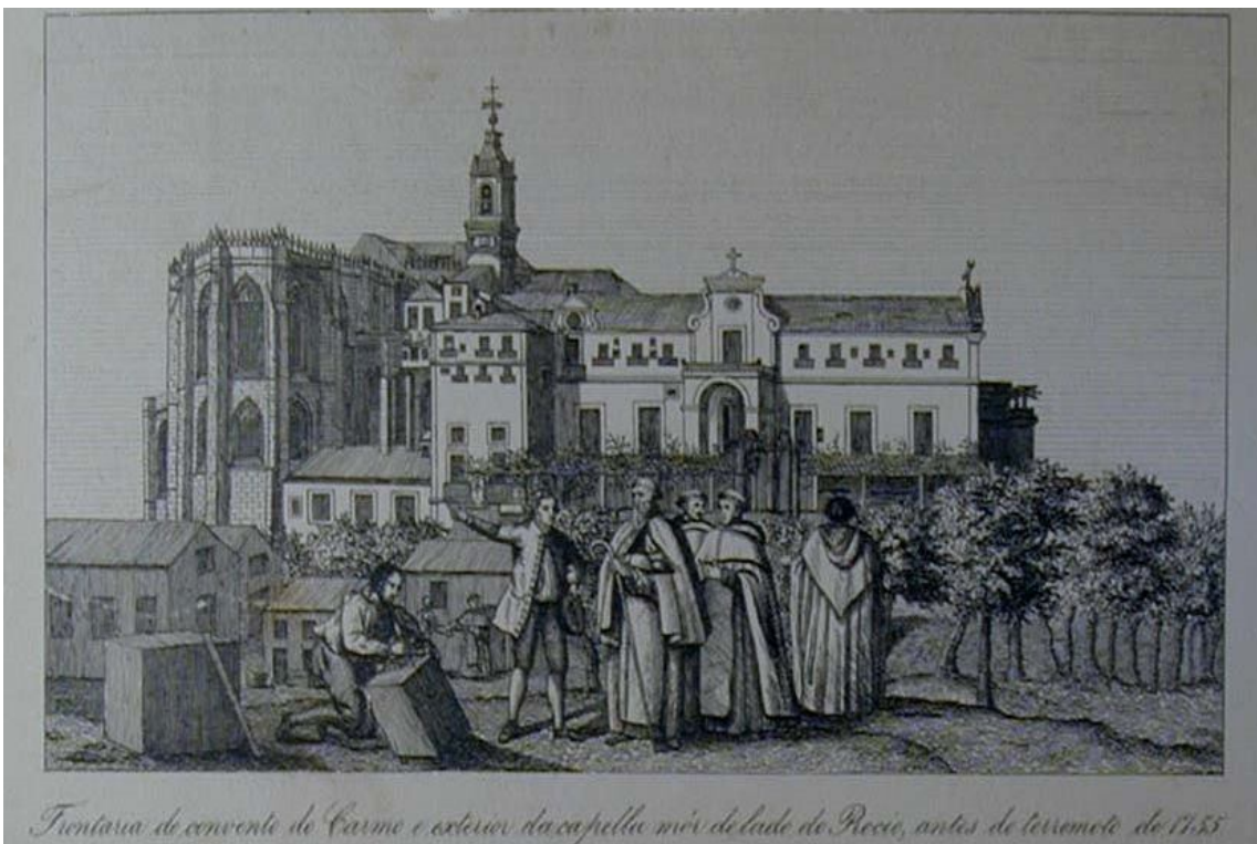
Figura 18 - Vista das traseiras da Igreja e Convento do Carmo, cerca de 1740, por G. Debrie (Fonte: Arquivo fotográfico de Lisboa).
