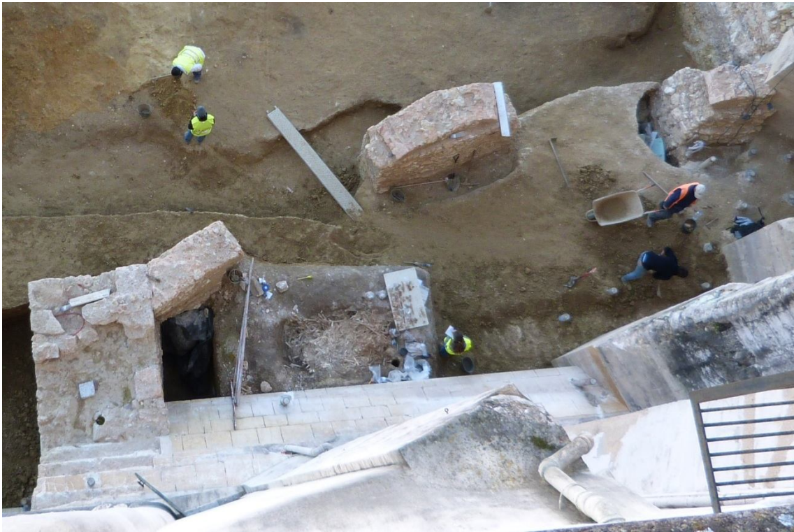
Figura 17 – Vista dos muros que constituem a estrutura de arcos de descarga (fotografia tirada durante os trabalhos, Novembro de 2013).
