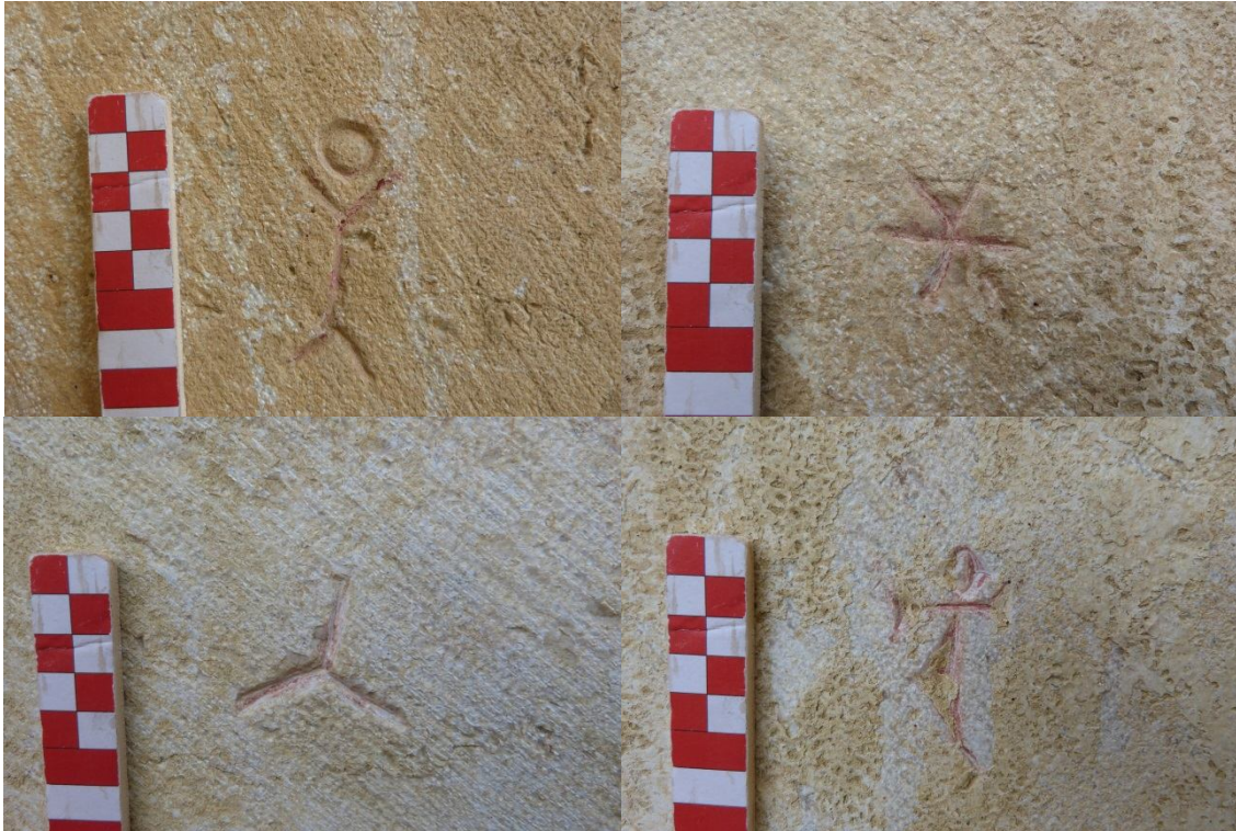
Figura 21 – Exemplos de marcas de canteiro ainda preenchidas com pigmento vermelho, na fachada tardez do Convento do Carmo (fotografias tiradas durante os trabalhos, Janeiro de 2014).
