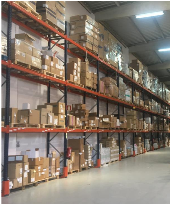
Figura 3.4 Racks da fila A
