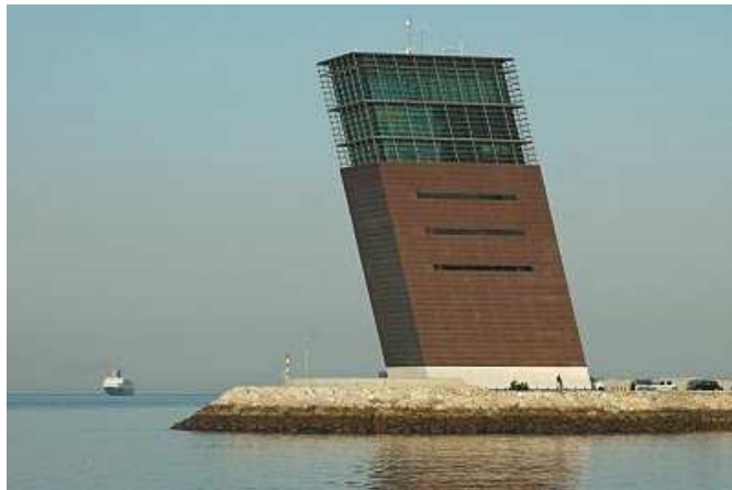
Figura 1 – Edifício do centro de coordenação e controlo de tráfego do porto de Lisboa com a fachada revestida com CBPB [ 2 ].
