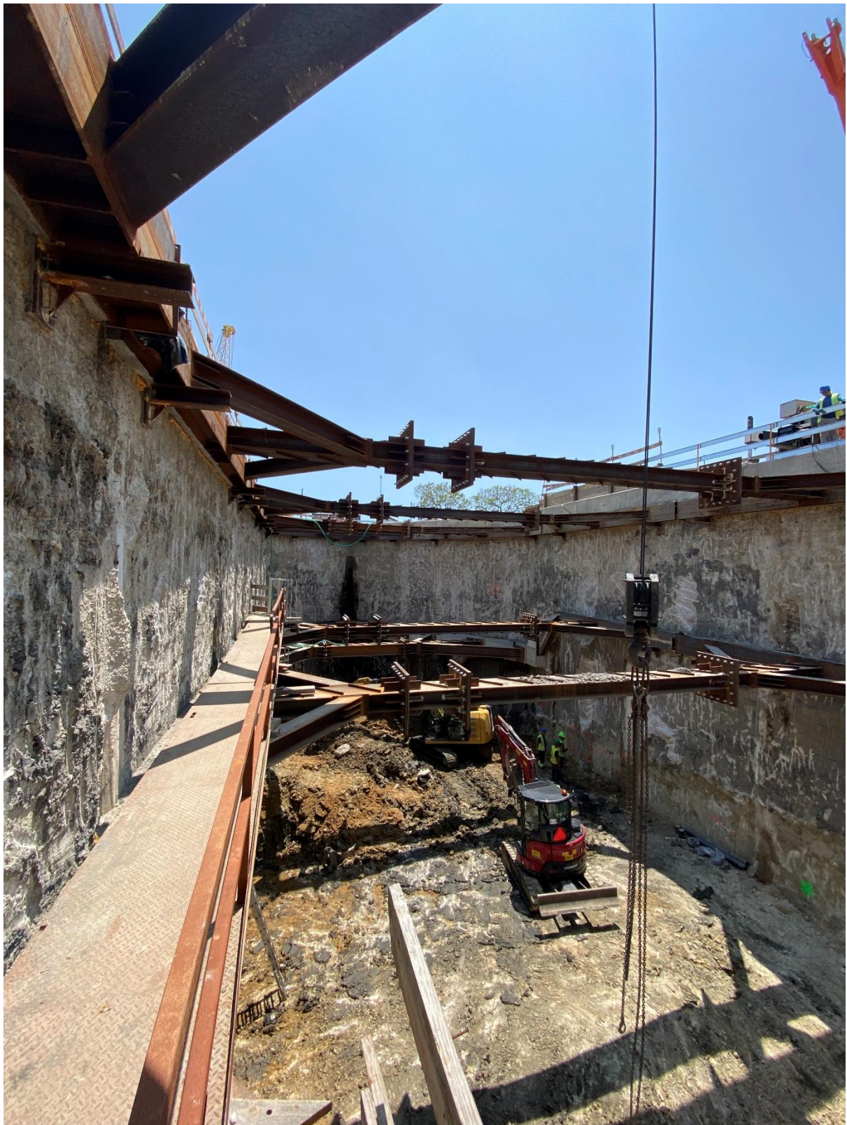
Figura anexo 7 - Aspeto final da parede moldada
