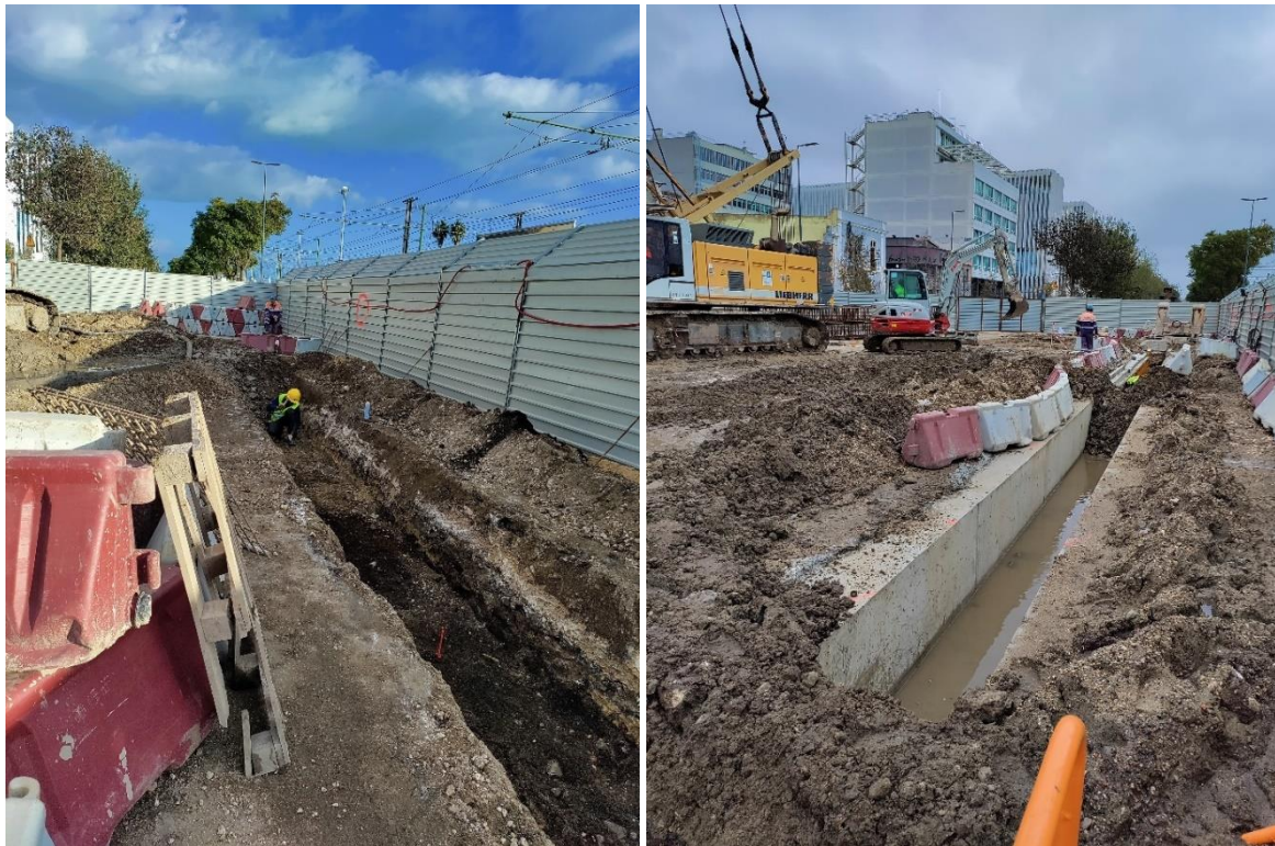
Figura 3.18 - Execução de vala para a construção de um muro guia (à esquerda) e muro guia já betonado (à direita).
