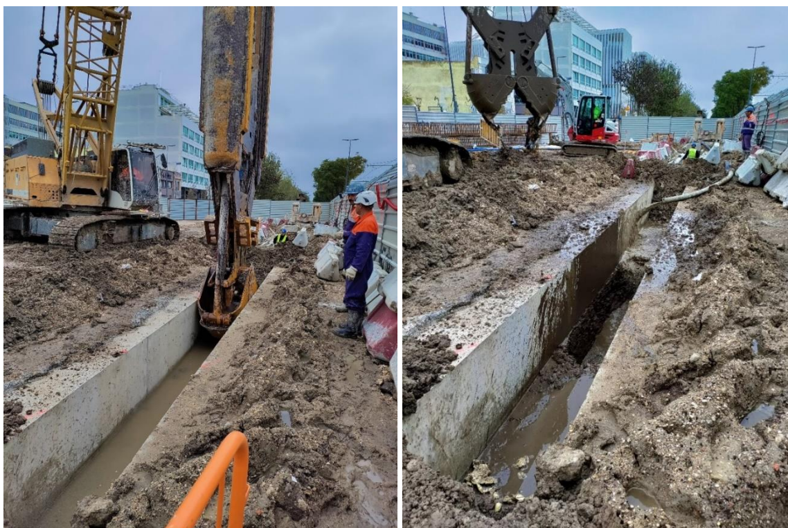
Figura 3.19 – Início da escavação com recurso a um balde de maxilas (à esquerda) e remoção dos detritos da escavação e início da bombagem de bentonite para o interior da escavação (à direita).
