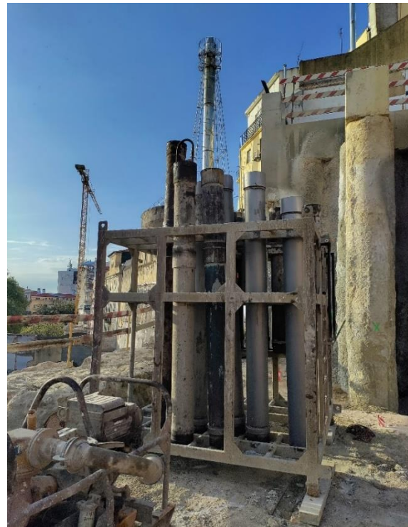
Figura 3.29 - Estrutura para armazenamento dos tubos de betonagem
