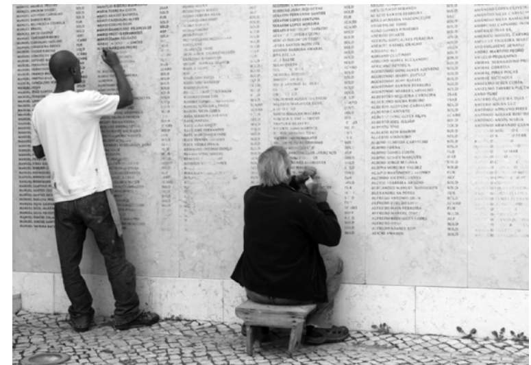
Imagem 3 – Restauro dos painéis
