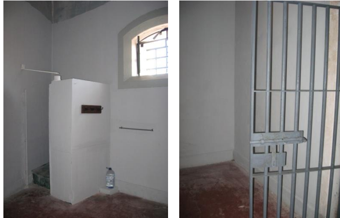
Fig. 51, 52 – Cella e porta de acesso na Ala H.
