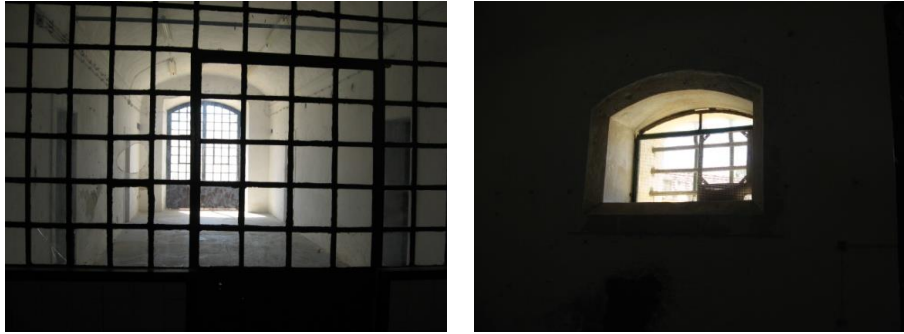
Fig. 25, 26 – (piso 0) Porta da ala B; Janela de meia-lua.
