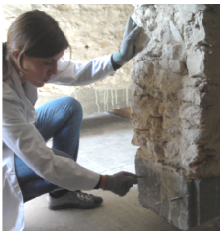
Fig. 5.2 – Colocação de varões roscados nos furos das faces laterais da base de apoio do murete
