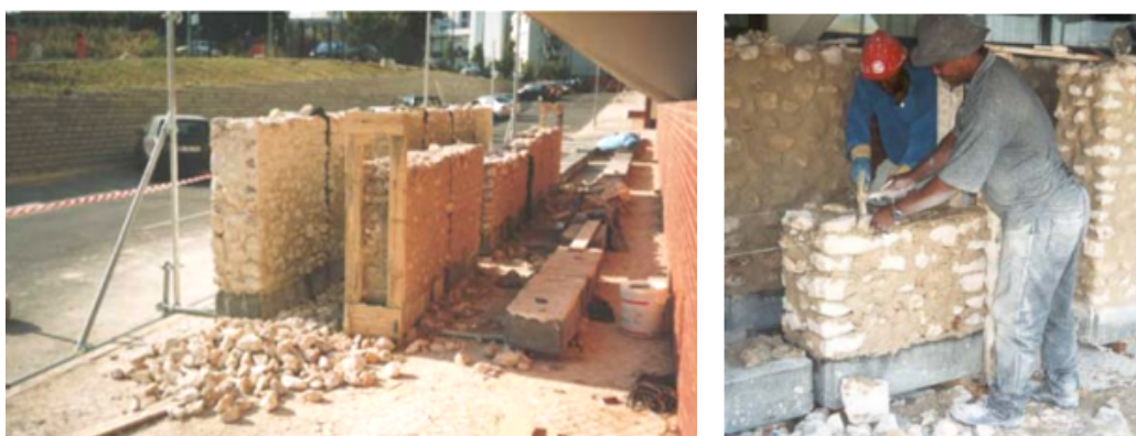
Fig. 4.1 - Construção dos muretes sobre bases em betão armado [42]
