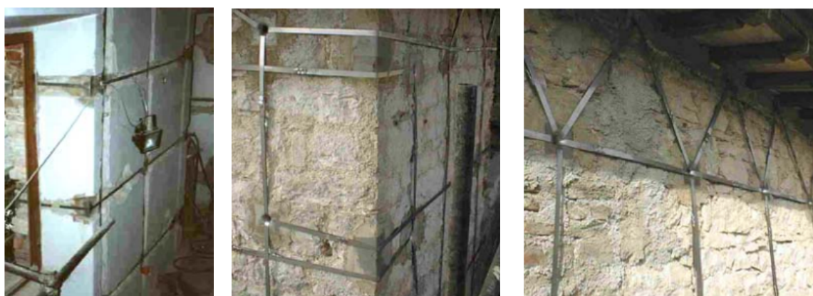
Fig. 3.21 - Aplicação do sistema CAM na reabilitação estrutural de um edifício [17]
