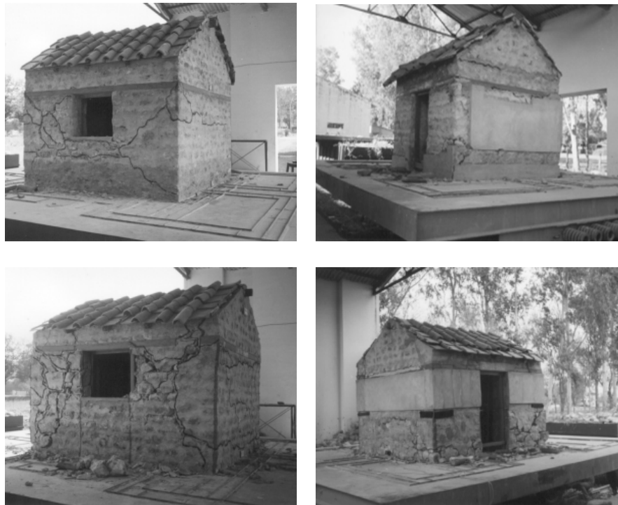
Fig. 3.19 - Danos ocorridos nos modelos 1 (em cima) e 2 (em baixo), de T. Shashi e A. Pankaj, antes e após serem reforçados [52]
