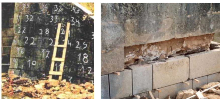
Fig. 2.16 - Exemplo de desmonte e reconstrução de uma parede de alvenaria de pedra [3]
