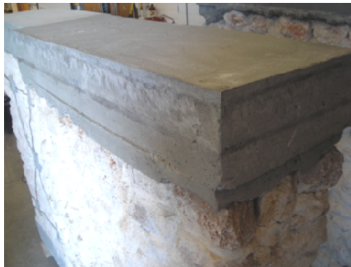
Fig. 5.4 – Aspecto final do lintel do murete
