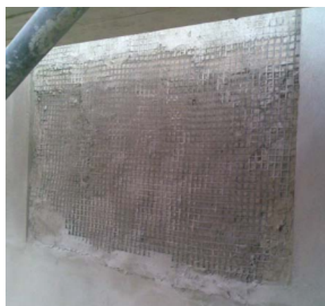
Fig. 2.13 - Aplicação de rebocos armados na consolidação de paredes de alvenaria [29, 40]
