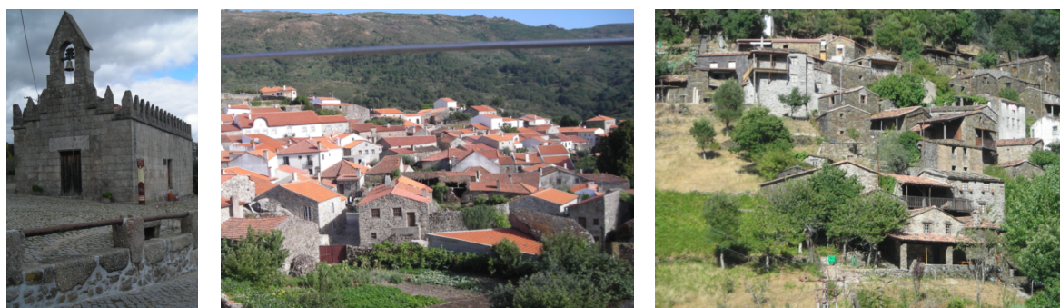
(a) – Fornos de Algodres; (b) - Linhares da Beira, alvenaria de granito do Séc. XVI; (c) - Serra da Lousã, alvenaria de xisto
