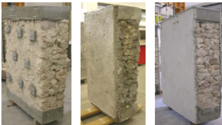
Fig. 4.2 - Exemplos de muretes após aplicação de alguns métodos de reforço [42]
