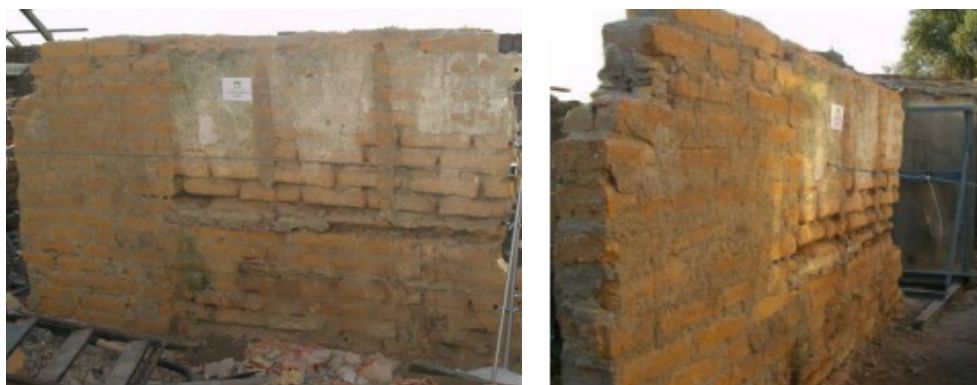
Fig. 3.13 - Parede ensaiada in-situ por H. Varum et al. [58]
