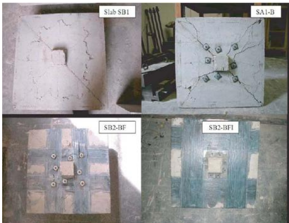
Figura 2.31 – Pormenor dos vários tipos de rotura obtidos e da fendilhação na face traccionada [17]
