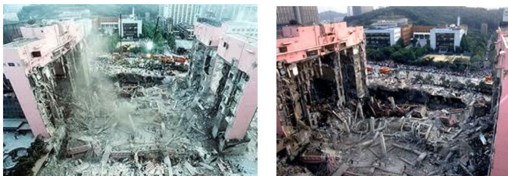
Figura 2.2 – Abatimento total do Centro Comercial Sampoong de Seúl, Coreia [20]
