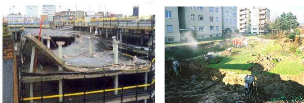
Figura 2.3 – Colapso do edifício Piper's Row Carpark em Inglaterra [46] e ruímento de uma garagem subterrânea na localidade Suíça de Gretzenbach [19]
