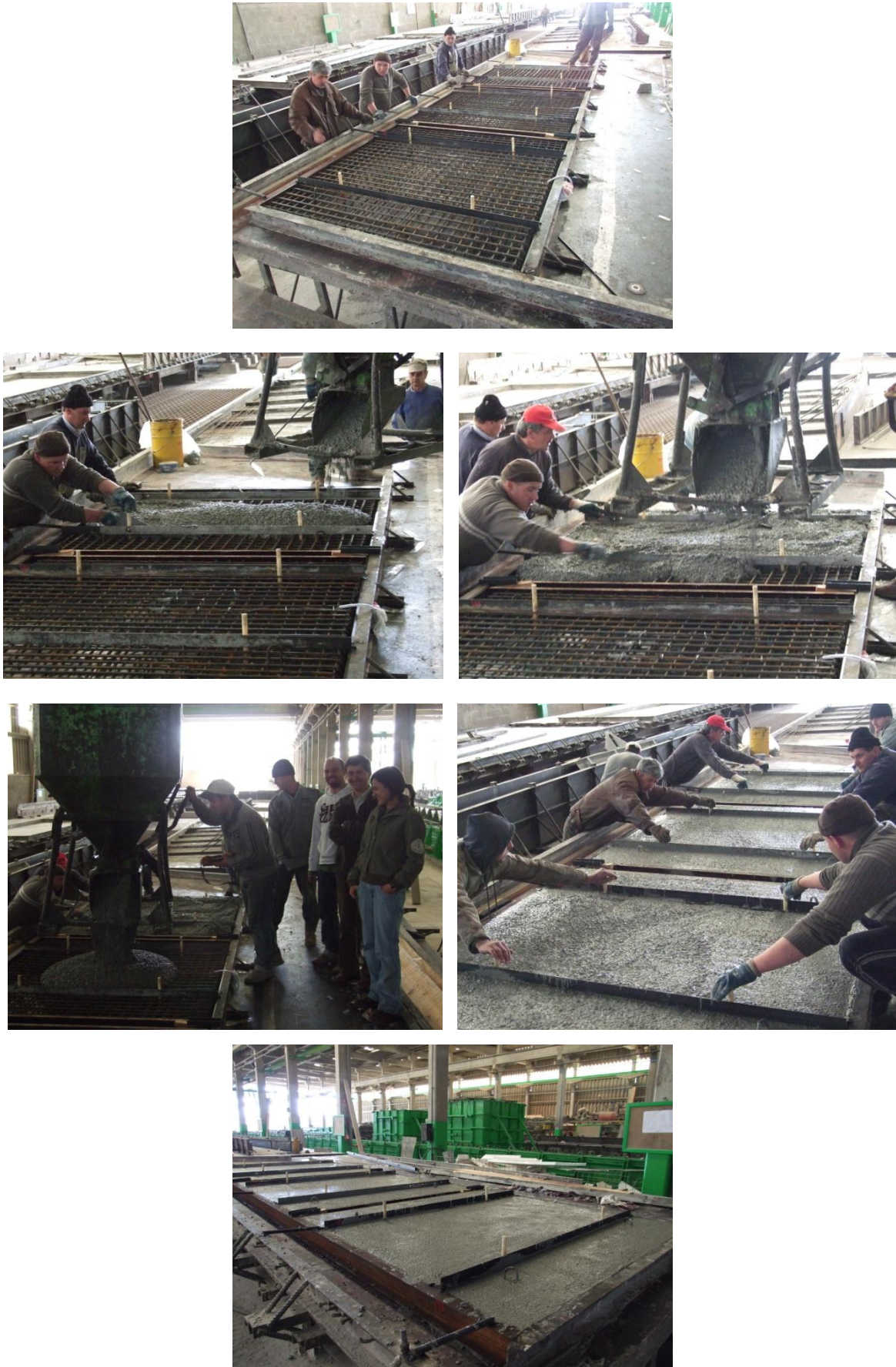
Figura I 3 – Betonagem e vibração dos modelos
