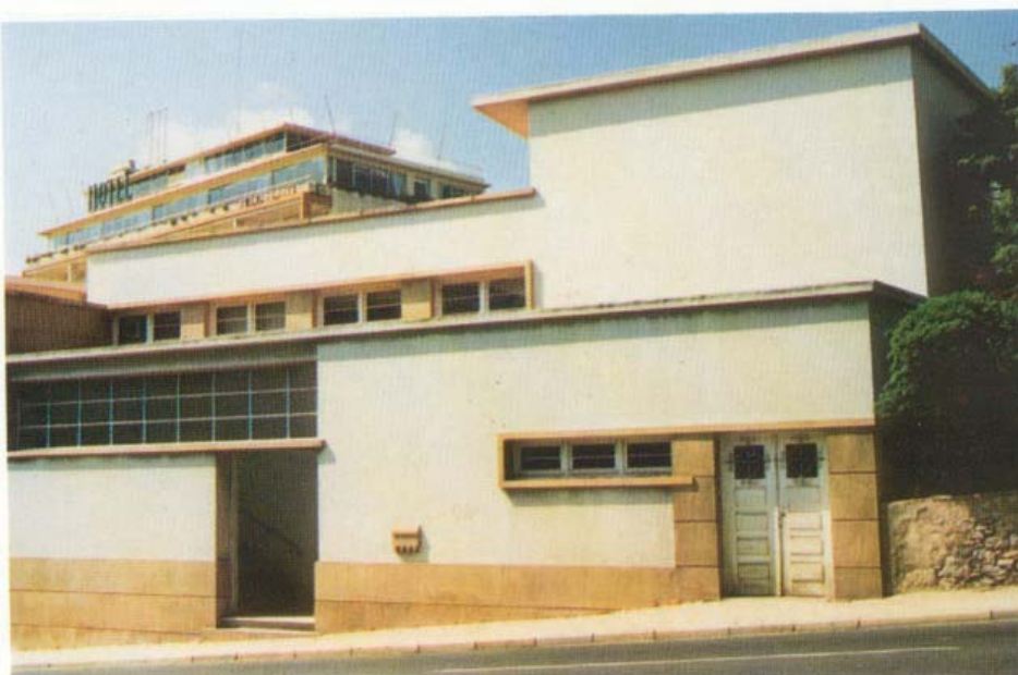
Figura 309 – Estoril, Av. Marginal/Av. de Nice, ed. dos Correios, Adelino Nunes, 1936 (fots. autora)
