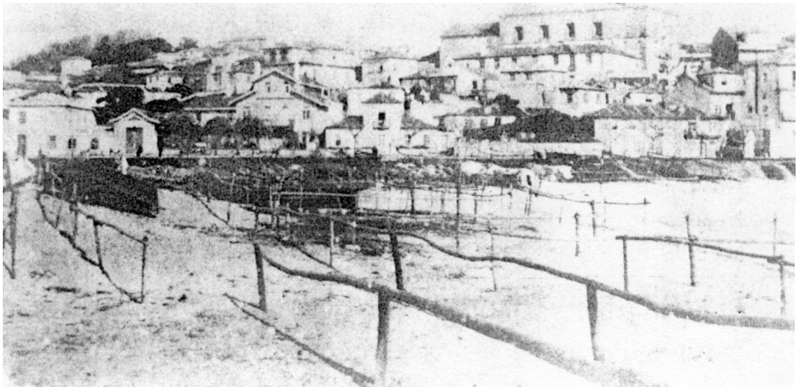
Figura 189 – Foz do Douro, local onde foi construído o jardim do Passeio Alegre ( idem )
