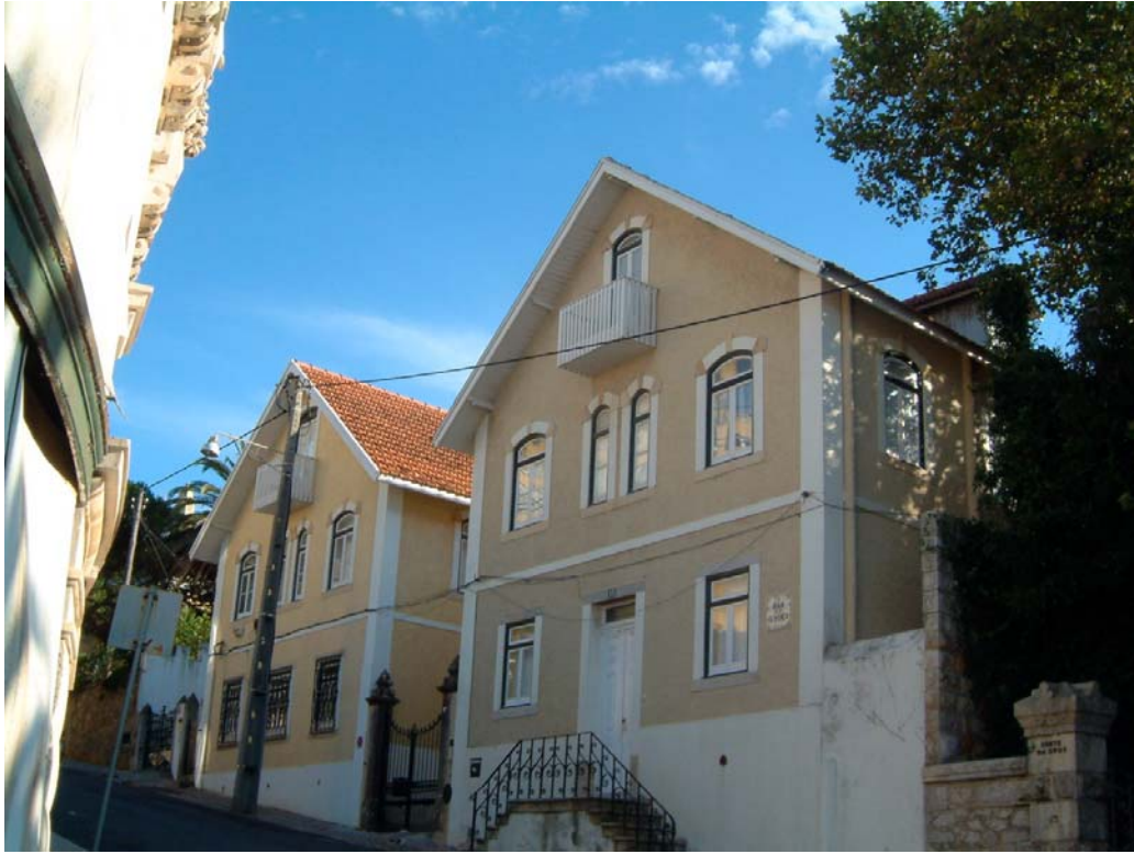
Figura 270 – Estoril, rua de Olivença, enc. Gen. Xavier Machado, 1897 (fot. autora)
