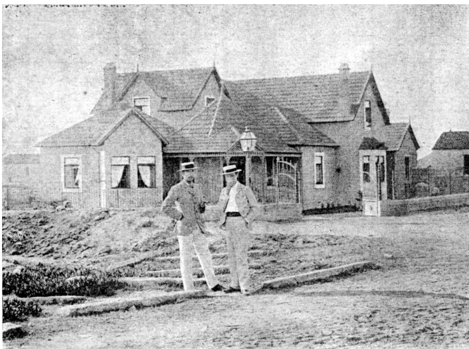
Figura 249 – Granja, Av. da República (antiga rua de trás)/rua Rocha e Melo, Villa Mar , William Pole Routh, enc, João Eduardo de Brito e Cunha, 1892 (fot. da casa acabada de construir) ( idem )
