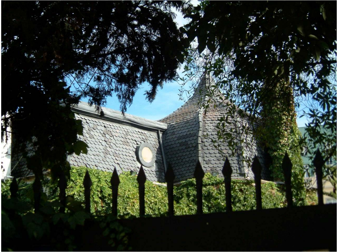
Figura 138 – Monte Estoril, Av. Dos Estrangeiros, telhados do nº227 (fot. autora)
