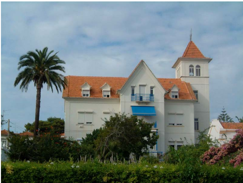
Figura 261 – Estoril, Alto Estoril, rua António Martins, Gaston Landeck, enc. Augusto Freire, 1899 (fot. autora)
