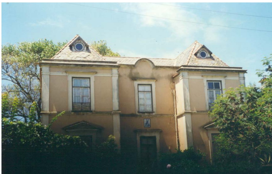
Figura 247 – Granja, cont. da “Avenida” para norte, casa de D. Eugénio Sellès, c. 1890 (fot. autora)
