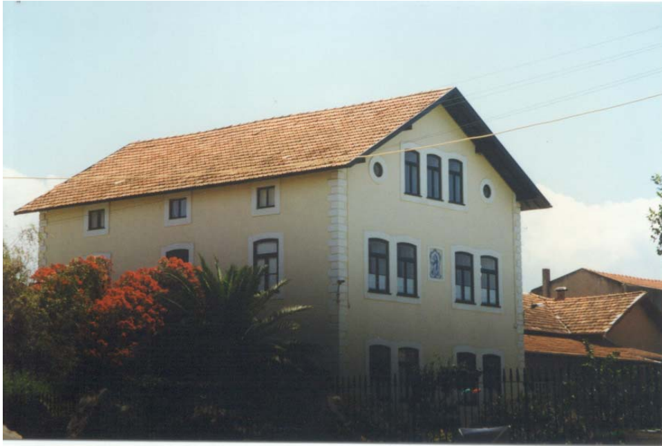
Figura 243 a – O chalet Daupias no seu estado actual (fot. autora)
