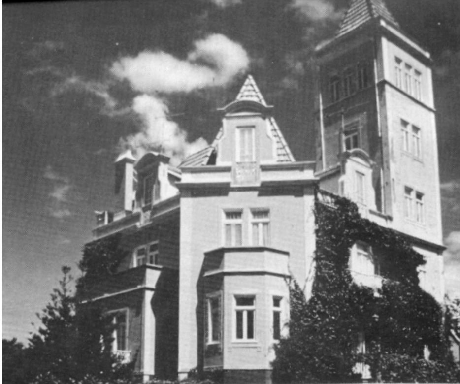
Figura 177 – S. J. do Estoril, rua Vasco da Gama, Casa da Torre , enc. António Gonçalves de Azevedo, Gaston Landeck, 1901 ( Arquivo de Cascais, B.C.M. )
