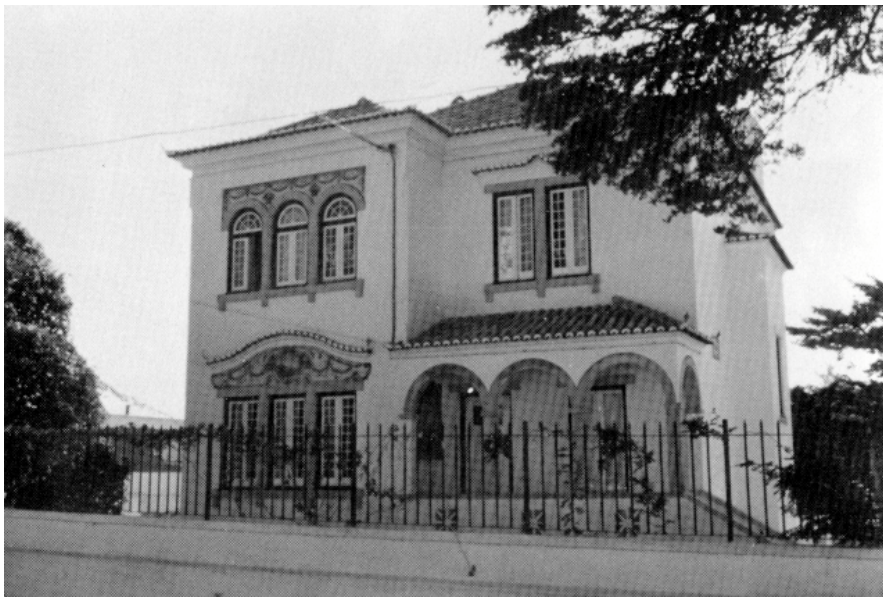
Figura 296 – Estoril, rua da Beira Litoral, Shalimar , enc. e proj. Jorge Pereira Leite (fot. autora)
