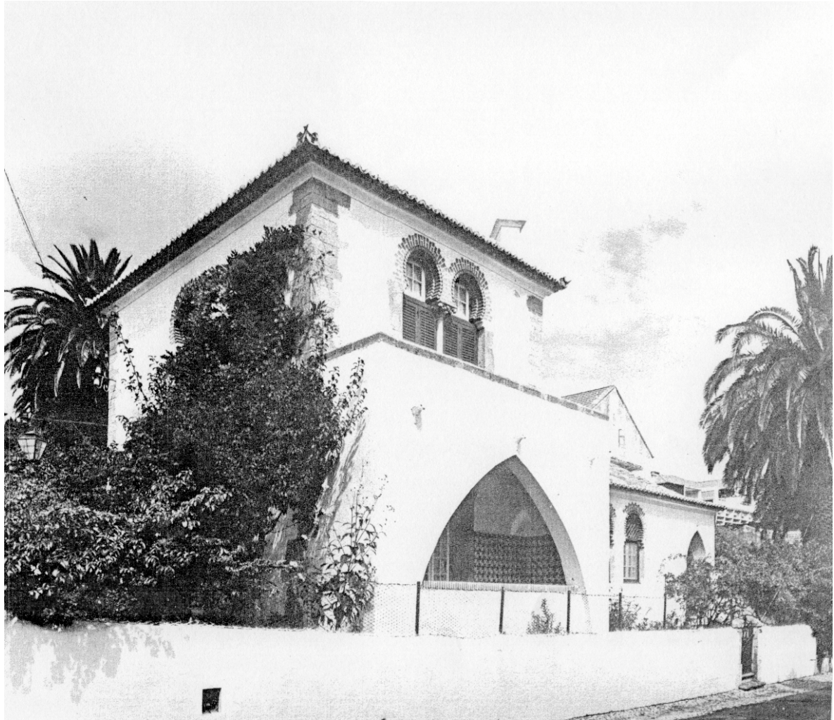
Figura 147 – Monte Estoril, Rua Conde de Moser/Av. Das Acácias, casa Silva Gomes, Raul Lino, 1899 ( Raul Lino-Exposição Retrospectiva )
