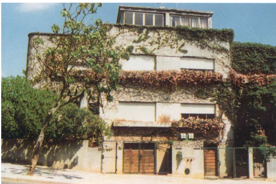
Figura 318 – Estoril, Av. General Carmona, moradias geminadas, “Vale Florido”, Luís Cristino da Silva, 1939 (fot. autora)
