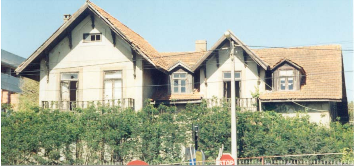
Figura 238 a – O chalet Espregueira, estrada de Espinho, no seu estado actual (fot. autora)
