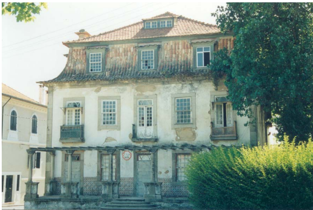
Figura 232 b – O edifício anterior no seu estado actual (fot. autora)
