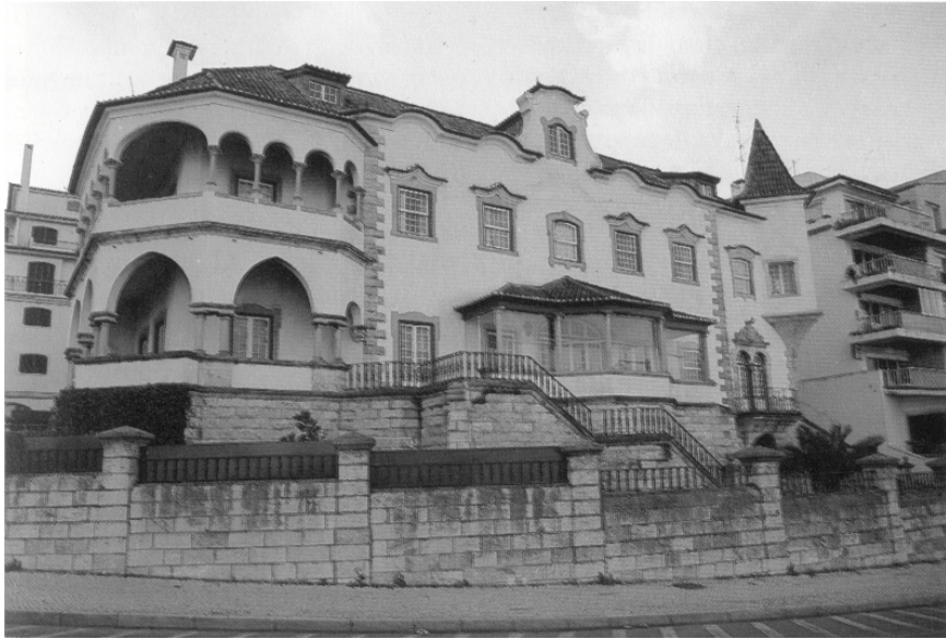
Figura 122 – Cascais, Av. D. Carlos I, casa dos condes de Monte Real, proj. Guilherme Gomes, 1920 (Cascais)
