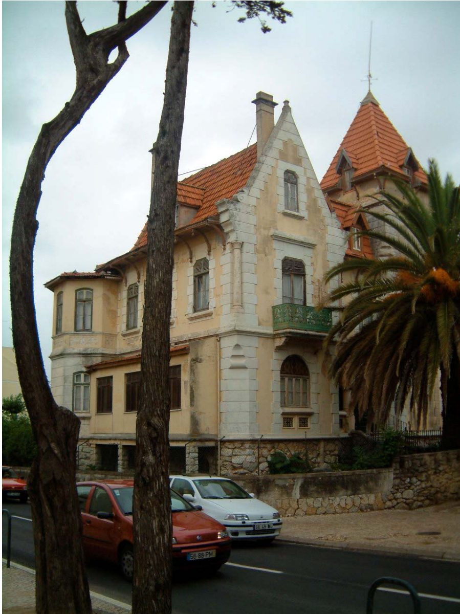
Figura 167 – S. J. do Estoril, Av. Marques Leal, Villa Grinalda, enc. John Watts Garland, anos 90 do séc. XIX, (fot. autora)
