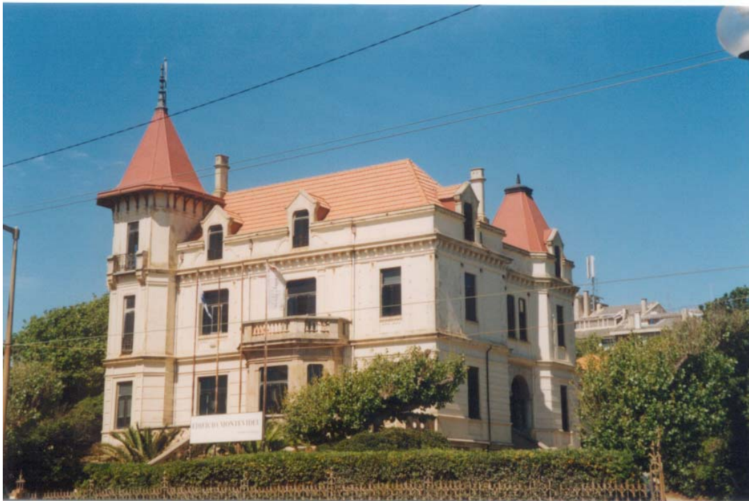
Figura 219 – Foz do Douro, moradias ainda existentes na rua Marechal Saldanha e na Av. de Montevideu (fots. autora)
