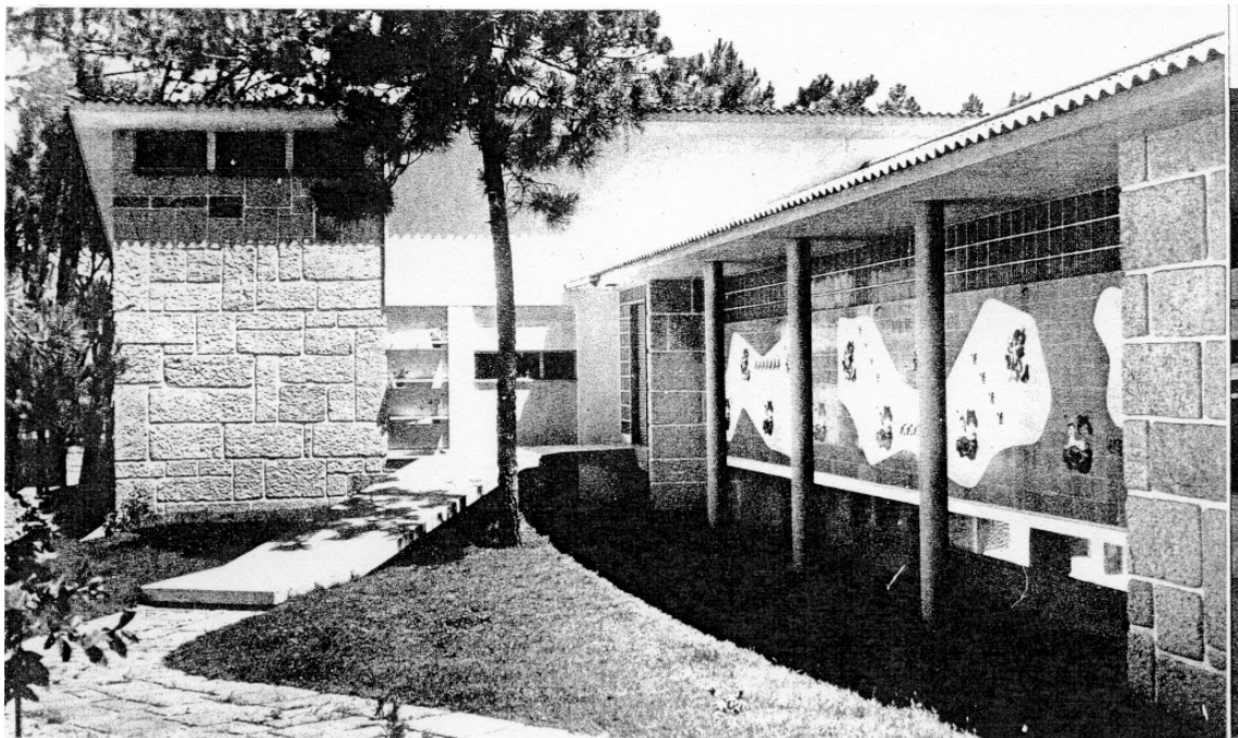
Figura 333 – Ofir, moradia, Arménio Losa e Cassiano Barbosa, 1950 ( ODAM Organização dos Arquitectos Modernos )
