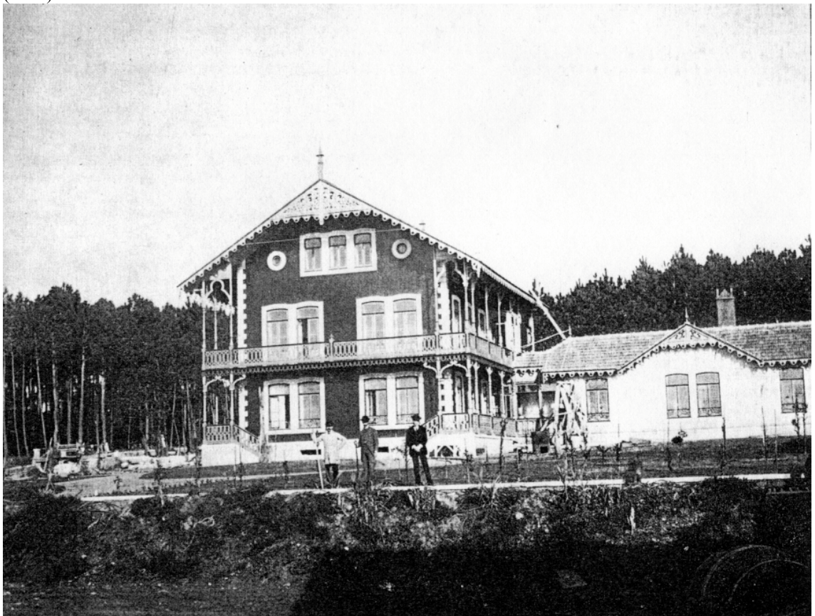
Figura 243 – Granja, nascente da via férrea junto ao pinhal, chalet do conde de Daupias, acabado de construir, 1884 ( idem )
